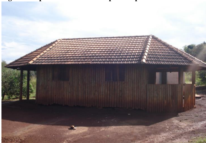
Figura 5. Tipo de casa construída pela Itaipu Binacional.
