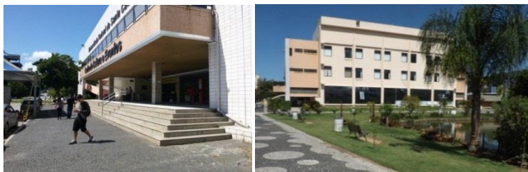
Figura 47: 1) escadaria em frente ao CE; 2) fachada oeste do CE (fotos da pesquisadora).
