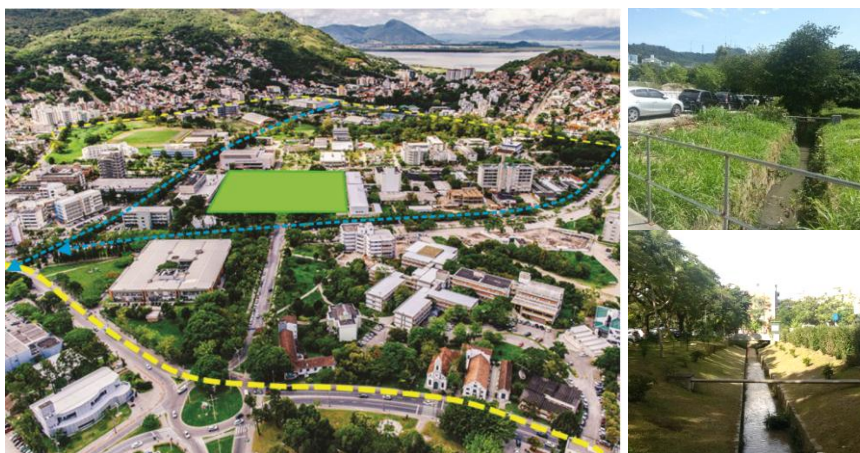
Figura 29: 1) área de planície da Bacia do Itacorubi, onde se localiza o Campus da UFSC (Praça da Cidadania), com destaque ao Rio da Carvoeira e o Rio do Sertão, que interceptam o campus; 2) e 3) canalizações do Rio da Carvoeira e do Rio do Sertão, na área interna do campus (elaborado pela pesquisadora).
