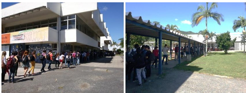
Figura 65: filas para acesso ao RU, com destaque à circulação coberta que leva à edificação (fotos da pesquisadora).
