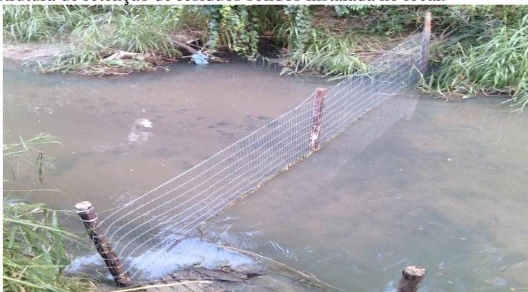
**Figura 9** Estrutura de retenção de resíduos sólidos instalada no Rio do Meio
