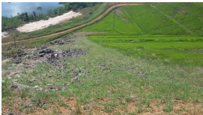
Figura 41 – Junção entre a barragem de enrocamento e terra da margem direita.
