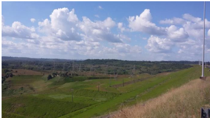
Figura 40 – Barragem de terra da margem direita.
