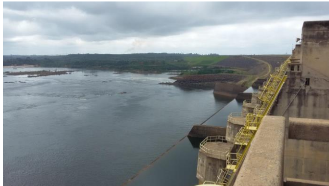
Figura 39 – Vista da barragem de terra e enrocamento da margem direita.
