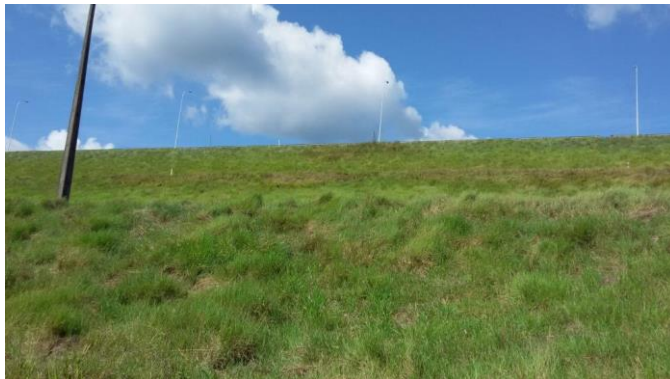
Figura 43 – Vista do cobrimento da face de jusante da barragem de terra da margem direita.
