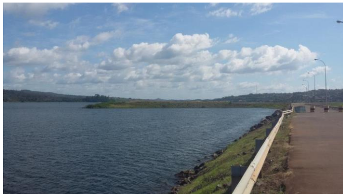
Figura 38 – Vista da barragem de terra da margem esquerda.
