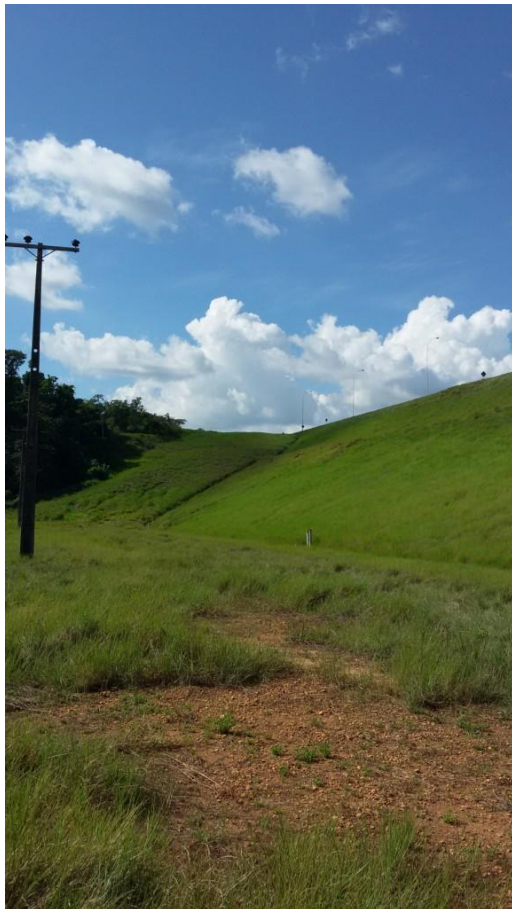
Figura 42 – Vista de jusante da barragem de terra da margem direita.
