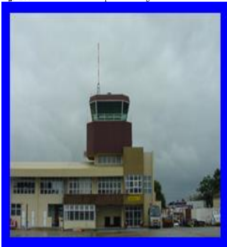
Figura 9. Torre de controle do aeroporto de Navegantes
