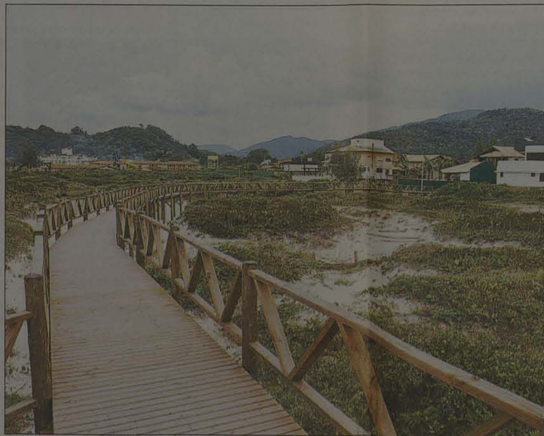
A passarela construída por moradores do condomínio Albatroz dá acesso privativo à orla
