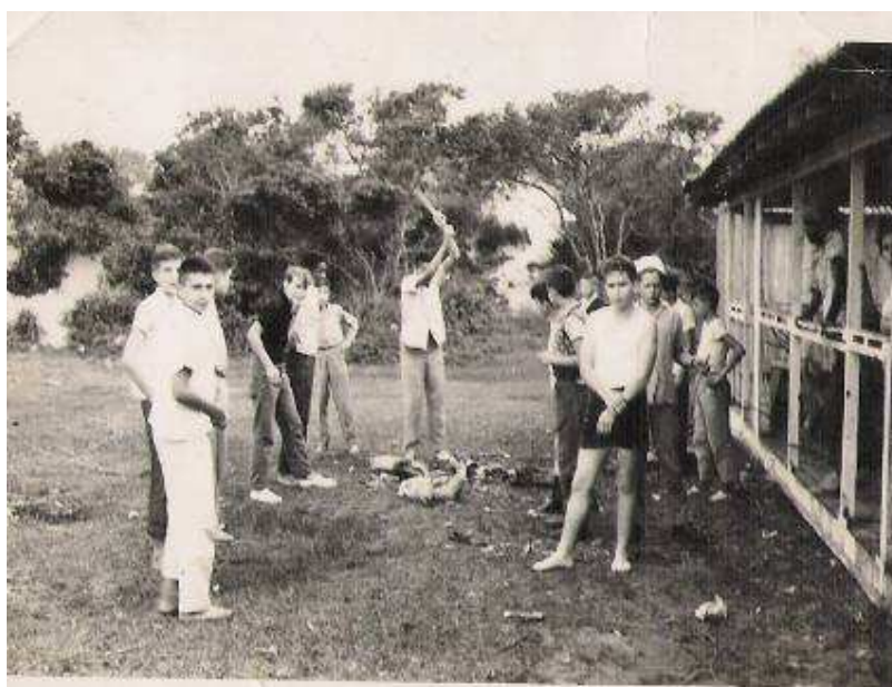
Fotografia 8: Escavando Fonte: Acervo particular da ex-aluna Marlete Mafra.
