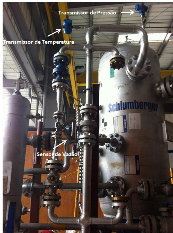
Figura 5.4: Sistema final de medição de gás
