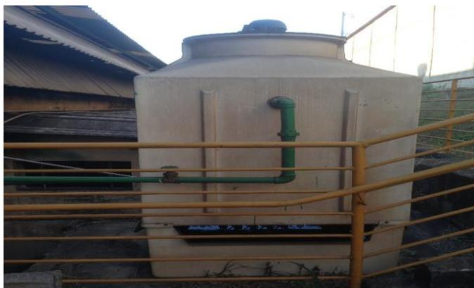
Figura 5: Trocador de Calor das Maquinas
