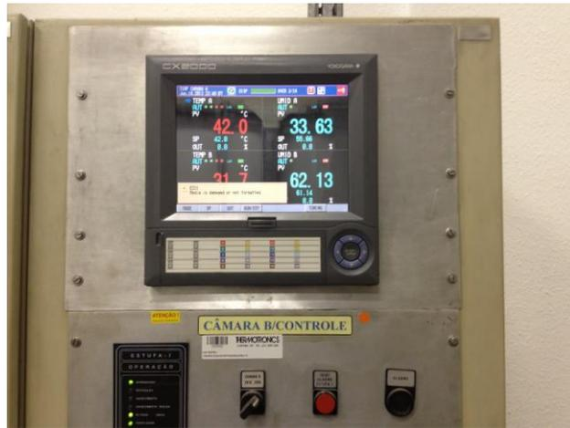
Figura 19. Controle de Temperatura - Temperatura 42°C
