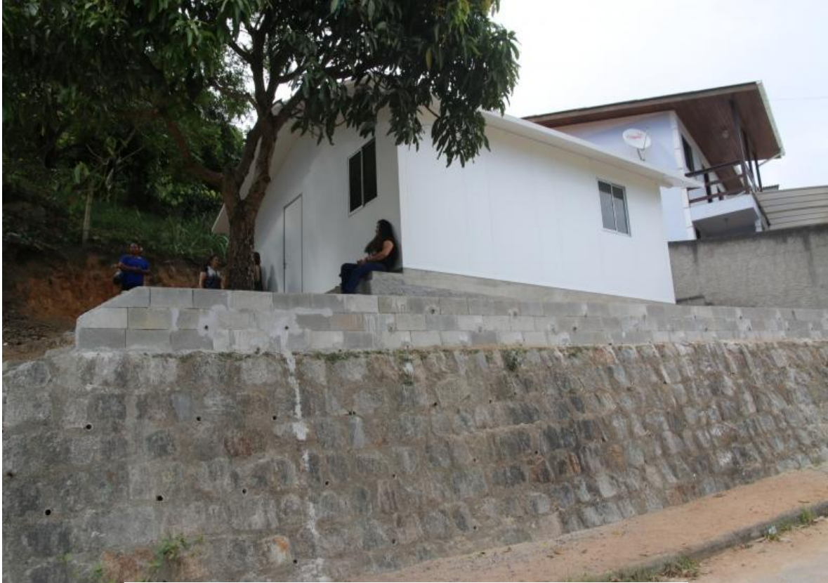
Casas Modular e muro de contenção para evitar possíveis deslizamentos (Comunidade Alto da Caeira)
