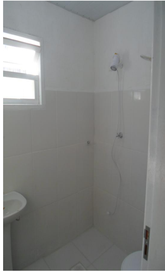
Registro fotográfico da situação do banheiro pós intervenção do PPMC/PAC.
