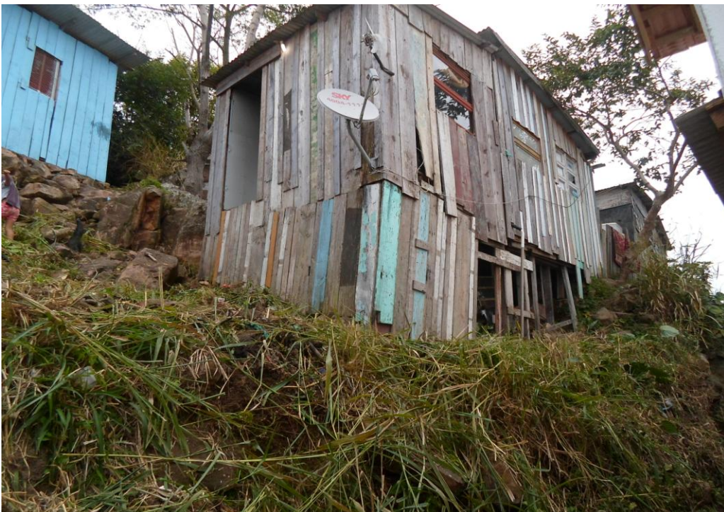
Casa localizada no morro Santa Vitória no MMC.
