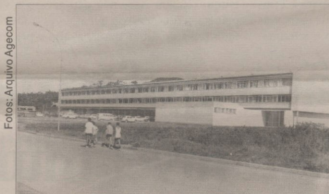
Prédio do Centro de Estudos Básicos, em 1970
