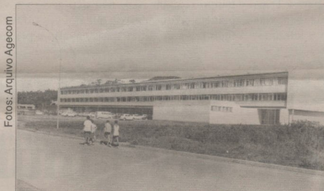
Prédio do Centro de Estudos Básicos, em 1970
