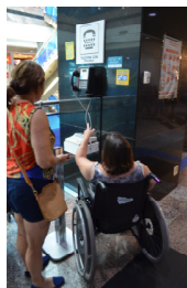
Figura F: Identificação do telefone, em altura inadequada e com obstáculo que impossibilitava sua aproximação.
