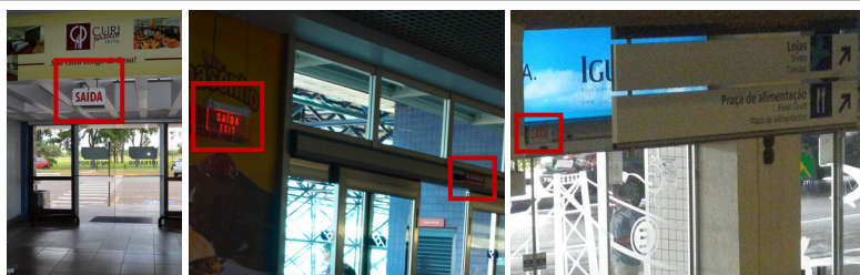
Figuras 75a, 75b, 75c: Sinalização visual de saída nos terminais de Pelotas, Porto Alegre e Florianópolis, respectivamente (da esquerda para a direita), são ofuscadas por propagandas ou outras informações nas três edificações.
