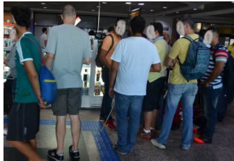
Figura 120: Utilização de pisos táteis instalados no interior do Terminal de Passageiros como sinalização direcional e de identificação de mudanças de direção.
