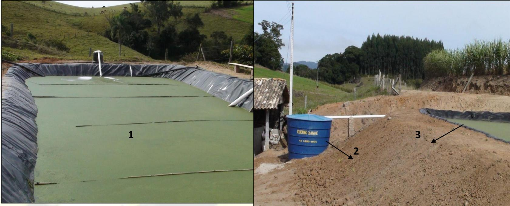
1- lagoa de lemnas utilizada no tratamento; 2- Reservatório para reuso do efluente tratado; 3- segunda lagoa de lemnas para o polimento do efluente.
