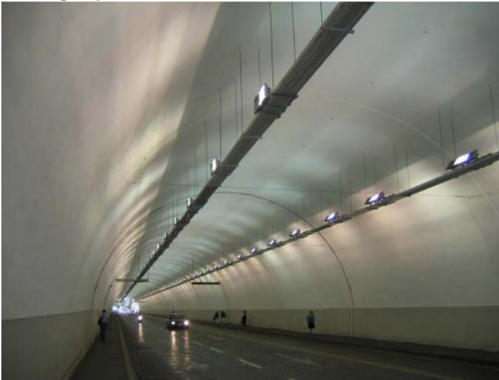
Figura 12. Aplicação de tinta fotocatalítica no túnel Umberto I, em Roma, Itália
