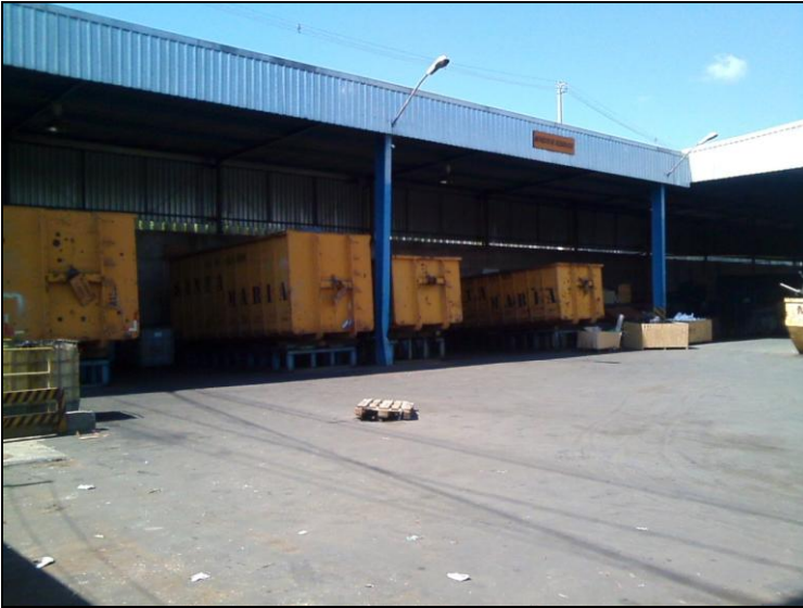
Figura 31: Depósito de Resíduos da empresa, onde os resíduos são armazenados temporariamente.
