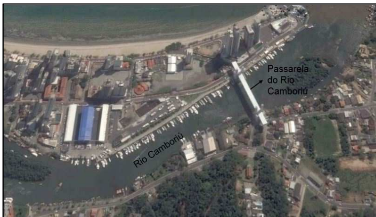
Figura 70: Passarela do Rio Camboriú, 2016.
