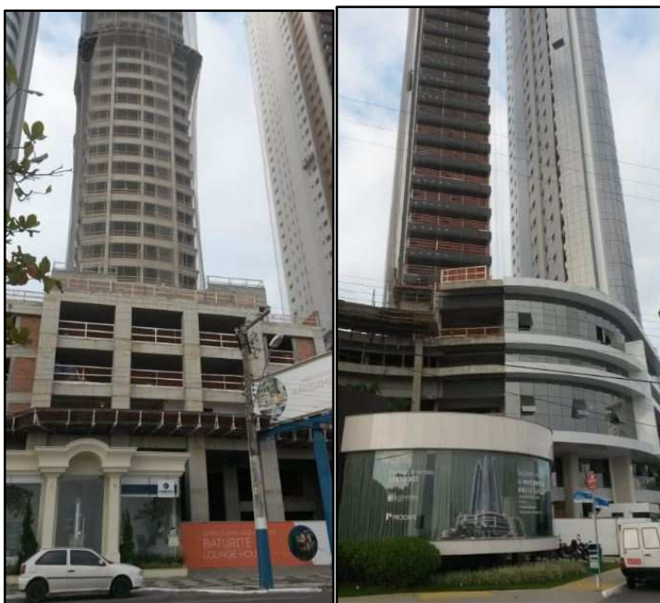
Figura 60: Edifício Baturité e Edifício Ibiza, respectivamente, 2014. Fonte: arquivo pessoal da autora.
