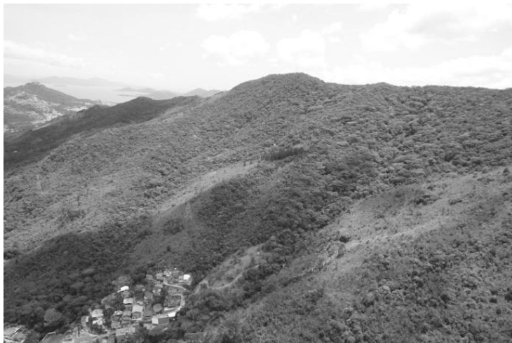
Figura 03 – Encosta do PMMC permitindo a visualização do estado atual de vegetação.
