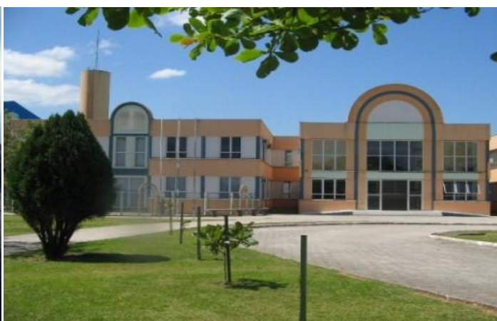
Fachada atual da escola
