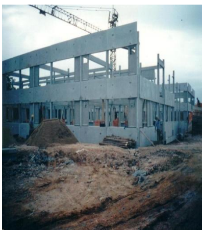
Construção da escola nova
