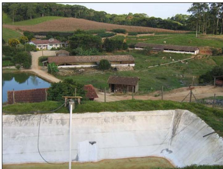
**Figura 3.** Lagoa de Armazenamento reformada (240 m<sup>3</sup>)
