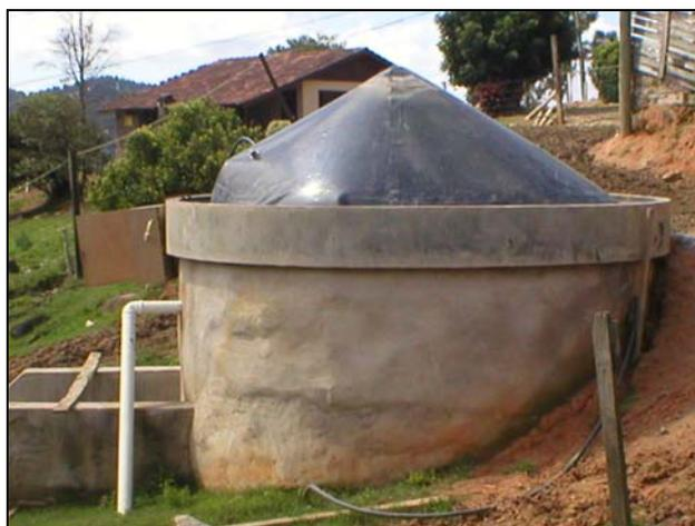
Figura 13. Biodigestor de lodo
