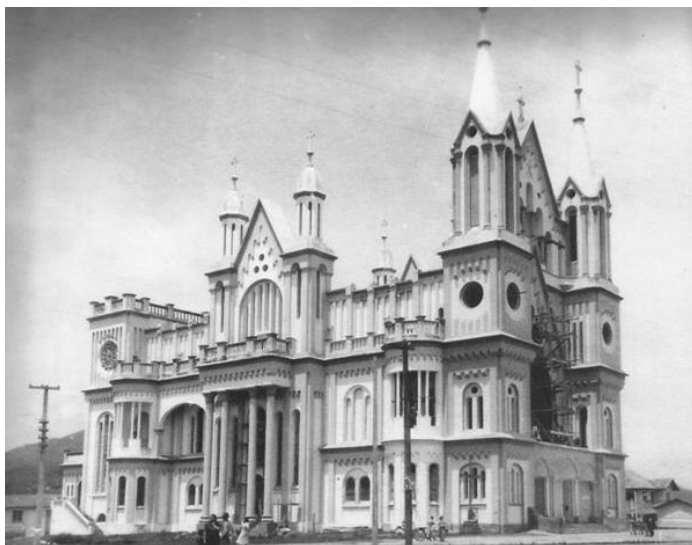
Figura 89: Vista da lateral esquerda (considerando a frente como referência). Na foto podem ser observados os andaimes montados para a troca do relógio. Década de 1960. Fonte: Centro de Documentação e Memória Histórica (CDMH) / Arquivo Público de Itajaí.
