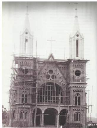
Figura 50: Ainda sem o segundo frontão, 1947. Fonte: < http://clubedoesentajatjai.blogspot.com.br/2012/11/construcao-da-nova-igreja-matriz-iii.html >. Acesso em: 01 out. 2015.
