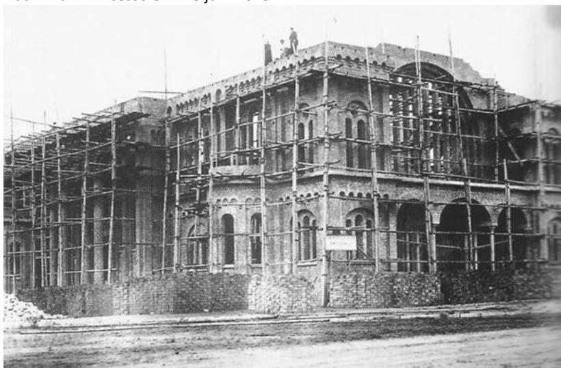
Figura 45: Construção da Igreja, parte frontal, 1942. Fonte: < https://www.facebook.com/photo.php?fbid=10203284785549280&set=gm.694016677328085&type=3 > . Acesso em: 05 maio. 2015.
