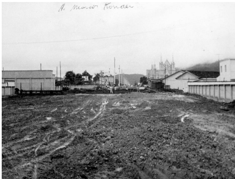
Figura 106: Obras de ampliação da Av. Vasconcelos Drumond no trecho próximo a Rua Samuel Heusi. Fonte: Centro de Documentação e Memória Histórica (CDMH) / Arquivo Público de Itajaí.
