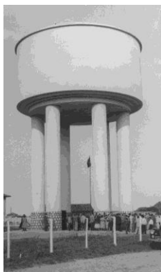
Figura 54: Foto da inauguração do reservatório na Praça da Igreja Matriz do Santíssimo Sacramento, mais precisamente à Rua João Bauer. Fonte: Centro de Documentação e Memória Histórica (CDMH) / Arquivo Público de Itajaí.
