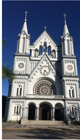
Figura 87: Foto externa, 2016. A principal alteração na fachada é a troca do relógio original. Fonte: Autora, 2016.
