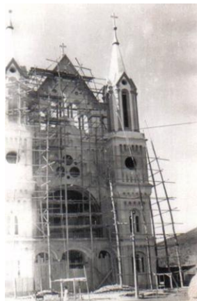
Figura 51: Fachada com andaimes, início da década da 1950. Fonte: < https://www.facebook.com/photo.php?fbid=10206404341809556&set=o.317816911614732&type=1 >. Acesso em: 08 set. 2015.
