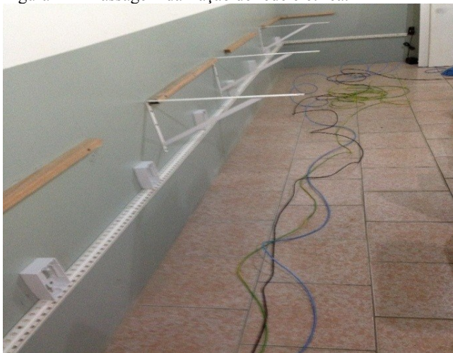
Figura 21 – Passagem da fiação de rede elétrica.
