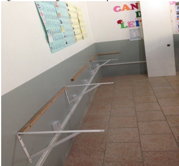
Figura 19 – Montagem da estrutura para as bancadas.
