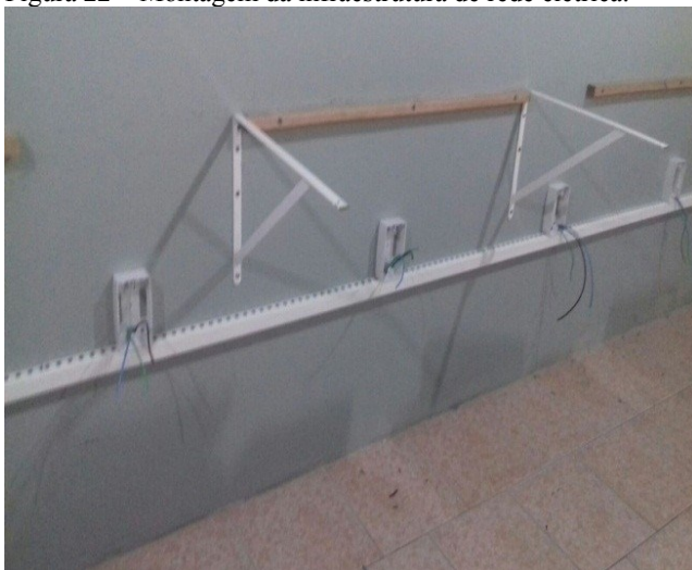
Figura 22 – Montagem da infraestrutura de rede elétrica.
