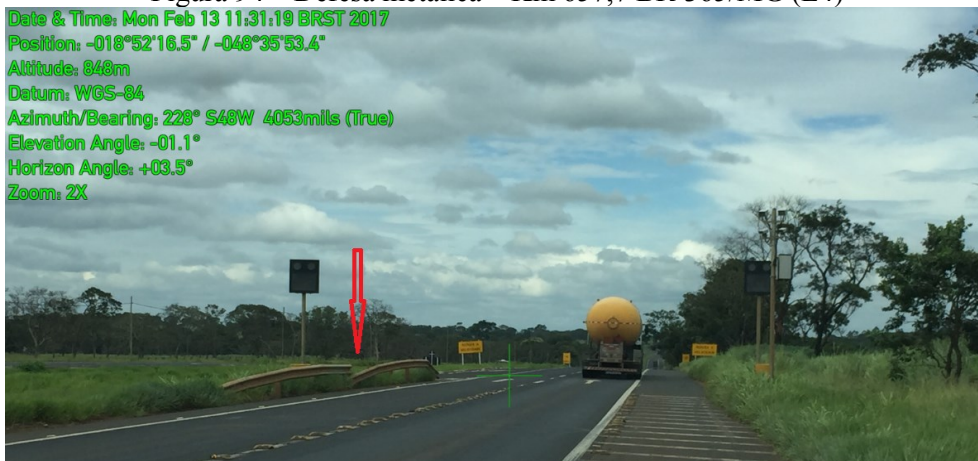
Figura 94 – Defesa metálica – Km 657,7 BR-365/MG (L4)
