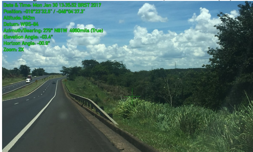
Figura 47 – Defesa metálica – Km 130,2 BR-050/MG (L2)
