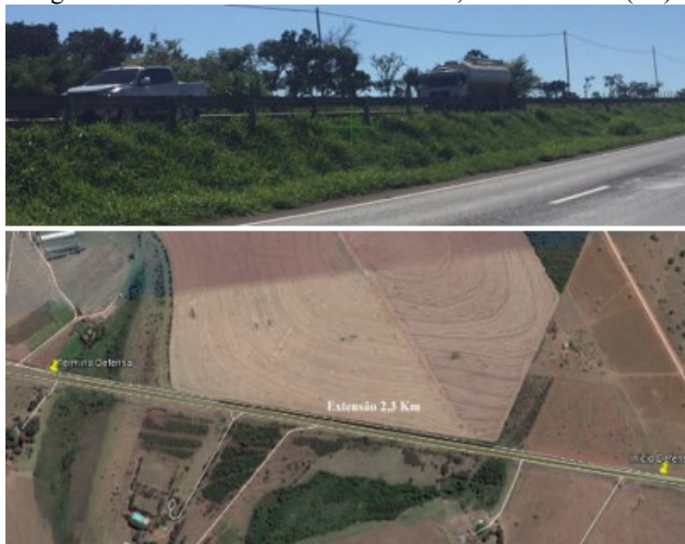
Figura 74 – Defesa metálica – Km 635,3 BR-365/MG (L1)
