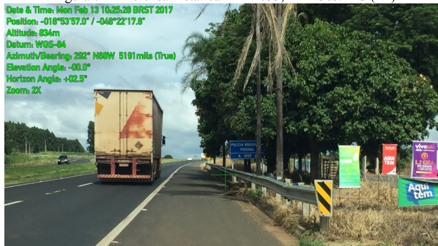
Figura 72 – Defesa metálica – Km 633,1 BR-365/MG (L1)
