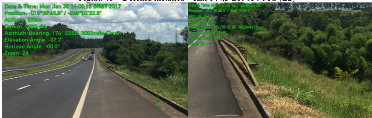
Figura 48 – Defesa metálica – Km 144,3 BR-050/MG (L2)
