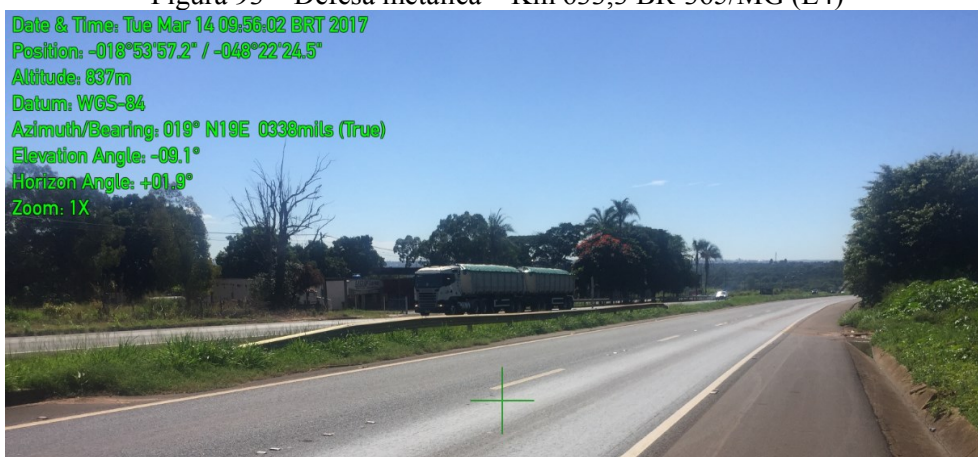
Figura 93 – Defesa metálica – Km 633,3 BR-365/MG (L4)
