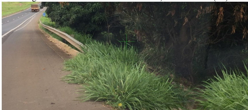
Figura 91 – Defesa metálica – Km 652,8 BR-365/MG (L2)
