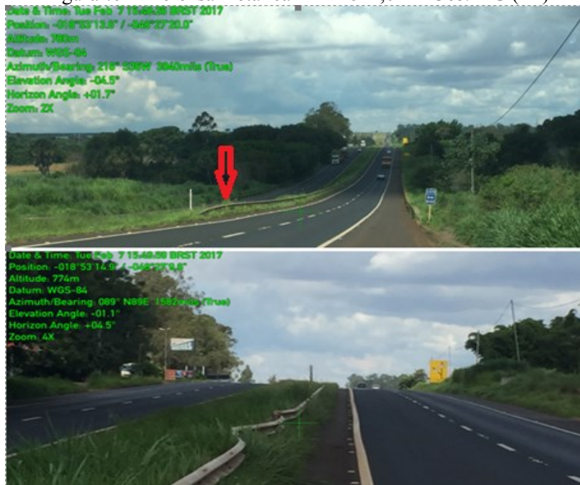
Figura 79 – Defesa metálica – Km 642,0 BR-365/MG (L2)
