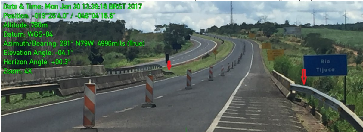
Figura 66 – Defesa metálica – Km 133,3 BR-050/MG – Rio Tijuco (L2)
