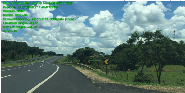
Figura 50 – Defesa metálica – Km 140,6 BR-050/MG (L2)
