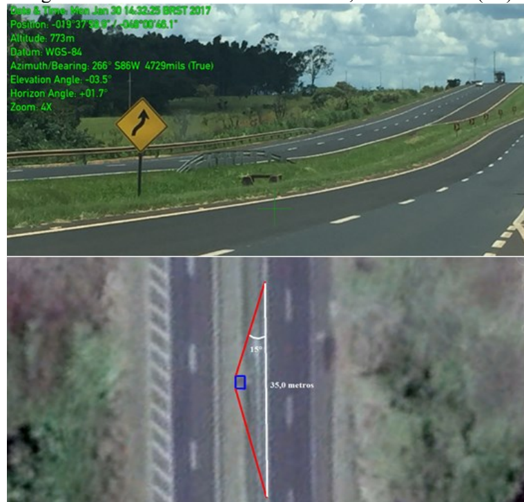
Figura 65 – Defesa metálica – Km 158,1 BR-050/MG (L5)
