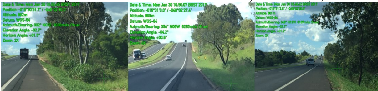
Figura 63 – Ausência de defesa metálica – Km 144,7 BR-050/MG (L5)
