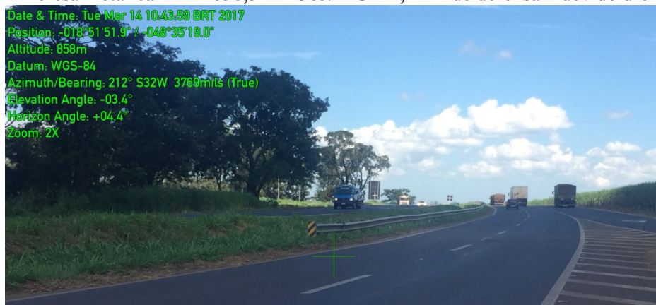
Figura 76 – Defesa metálica – Km 656,5 BR-365/MG – 1,2 km de defesa – devido drenagem (L1)
