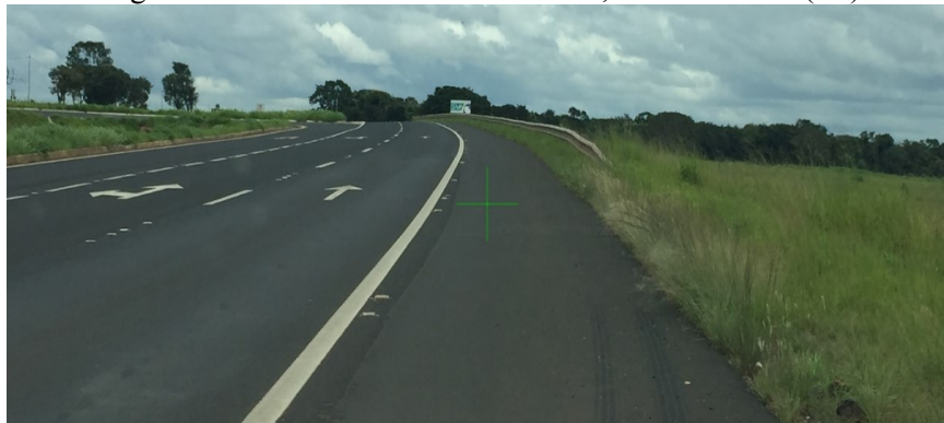
Figura 90 – Defesa metálica – Km 660,5 BR-365/MG (L2)
