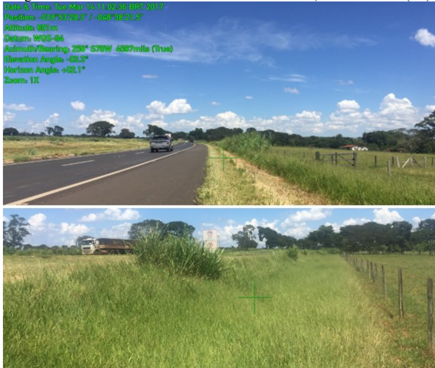
Figura 101 – Ausência de defesa metálica – Km 662,7 BR-365/MG (L5)
