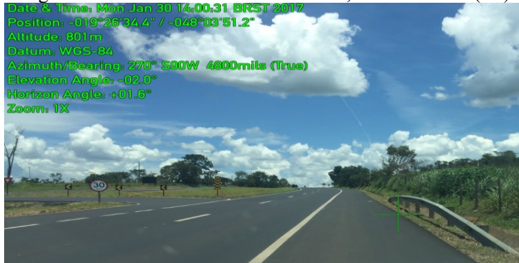
Figura 53 – Defesa metálica – Km 136,2 BR-050/MG (L4)
