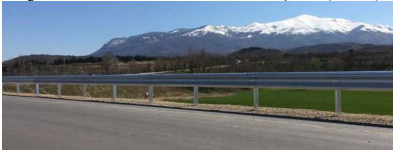
Figura 7 – Defesa metálica – Nível de contenção N2 (Normal).
