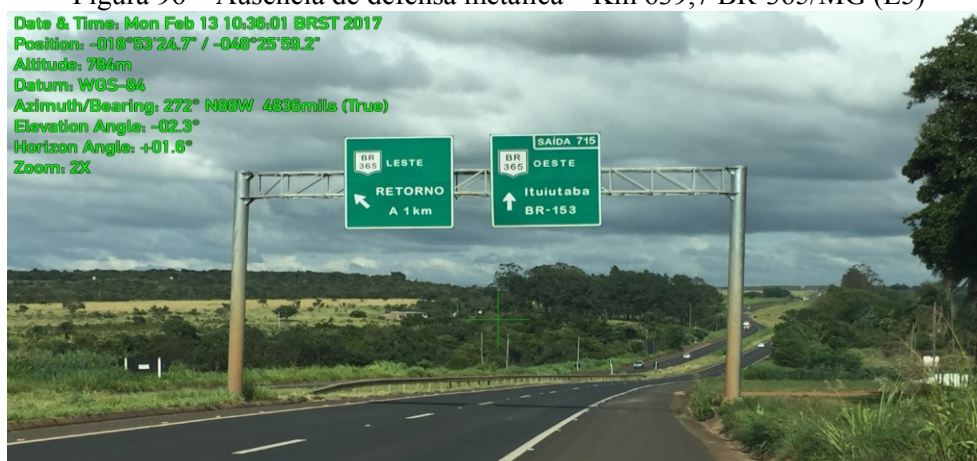
Figura 96 – Ausência de defesa metálica – Km 639,7 BR-365/MG (L5)
