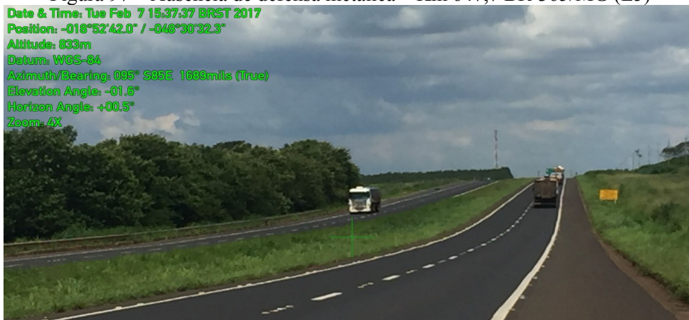
Figura 97 – Ausência de defesa metálica – Km 647,7 BR-365/MG (L5)
