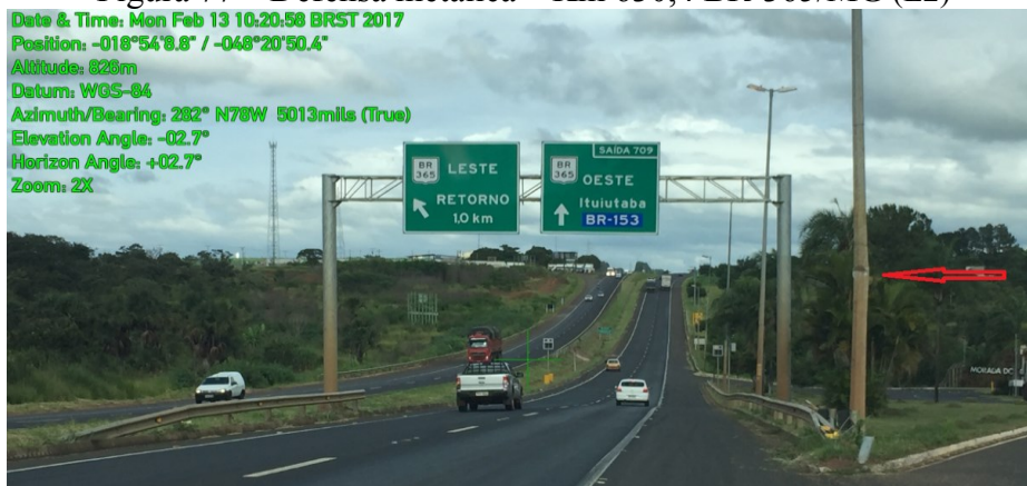
Figura 77 – Defesa metálica – Km 630,4 BR-365/MG (L2)
