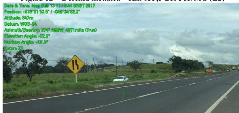
Figura 82 – Defesa metálica – Km 655,5 BR-365/MG (L2)
