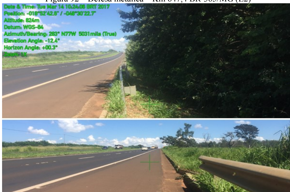
Figura 92 – Defesa metálica – Km 647,4 BR-365/MG (L2)
