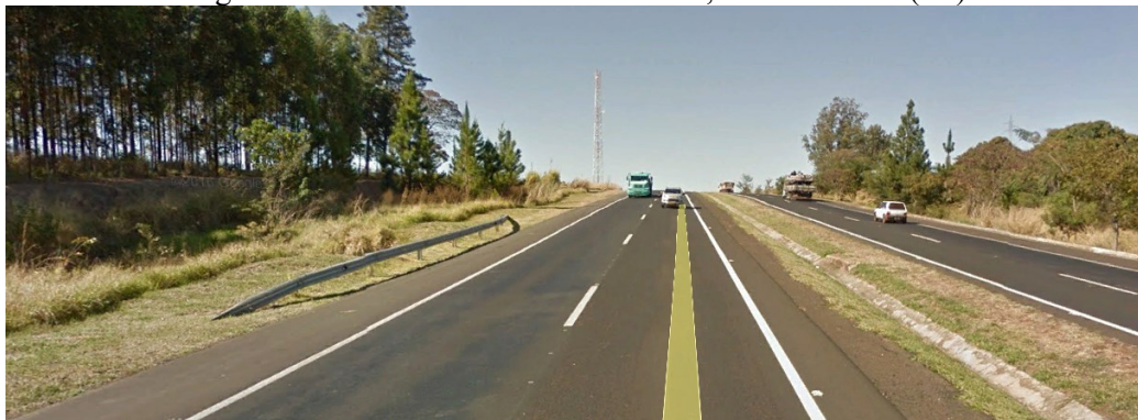
Figura 54 – Defesa metálica – Km 142,7 BR-050/MG (L4)
