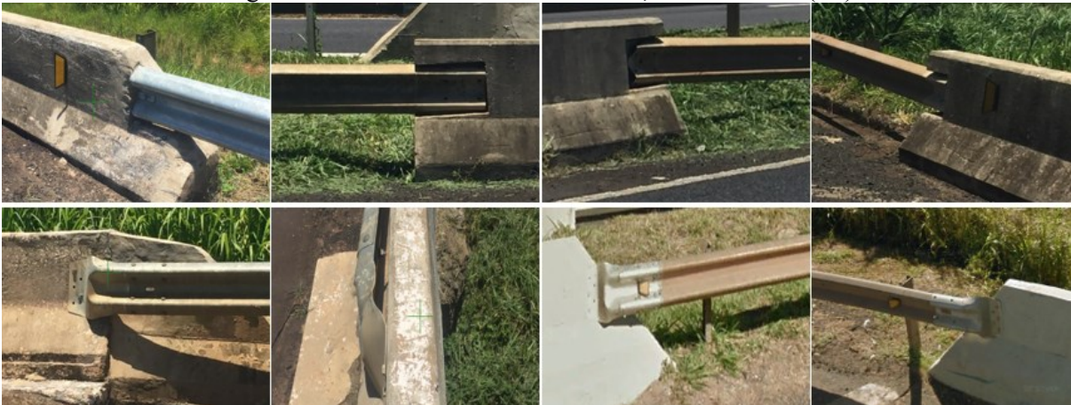
Figura 67 – Defesa metálica – Km 133,3 BR-050/MG (L2)
