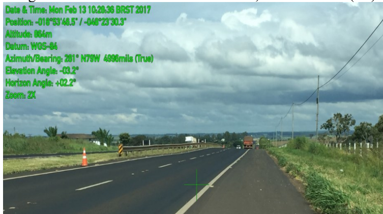
Figura 73 – Defesa metálica – Km 635,3 BR-365/MG (L1)
