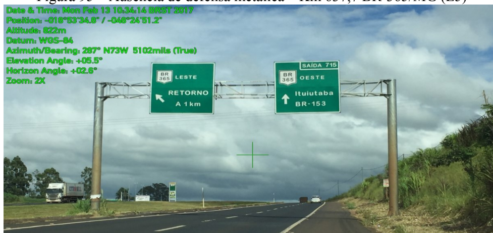
Figura 95 – Ausência de defesa metálica – Km 637,7 BR-365/MG (L5)
