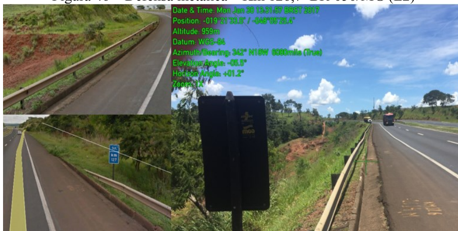
Figura 46 – Defesa metálica – Km 126,7 BR-050/MG (L2)
