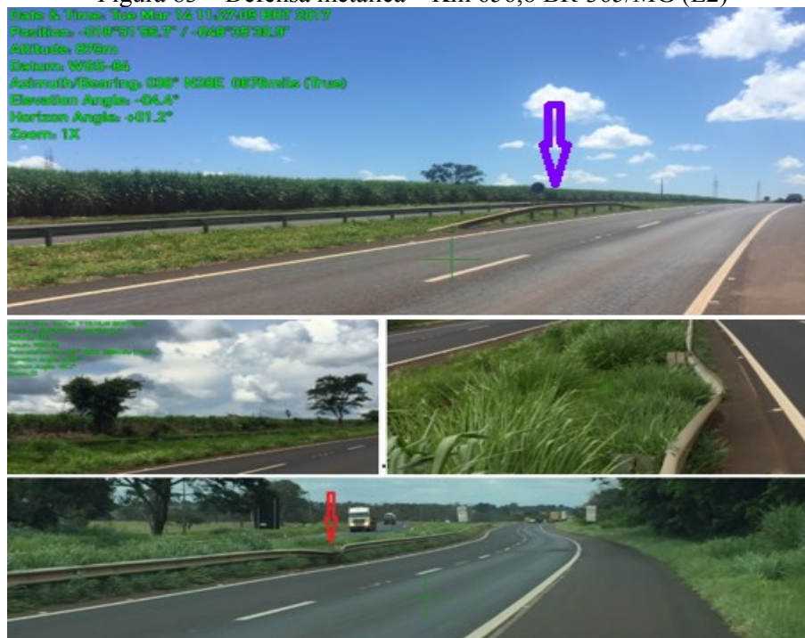
Figura 83 – Defesa metálica – Km 656,8 BR-365/MG (L2)
