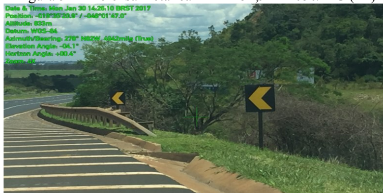
Figura 51 – Defesa metálica – Km 152,9 BR-050/MG (L2)
