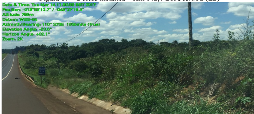
Figura 87 – Defesa metálica – Km 642,0 BR-365/MG (L2)
