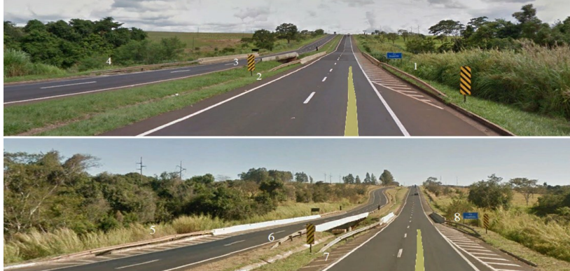
Figura 70 – Defesa metálica – Km 155,1 BR-050/MG – Rio Veadinho (L2)
