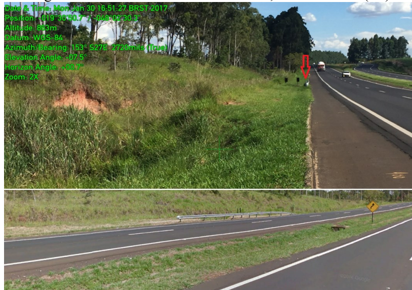
Figura 52 – Defesa metálica – Km 144,5 BR-050/MG (L2)
