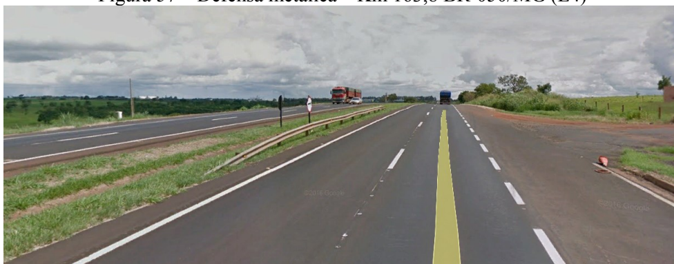
Figura 57 – Defesa metálica – Km 163,8 BR-050/MG (L4)
