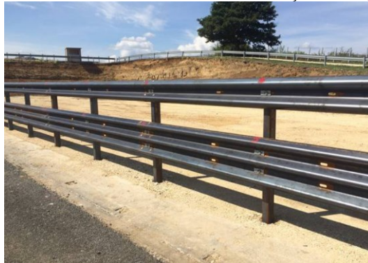
Figura 9 – Defesa metálica – Nível de contenção H4b (Muito Alta).
