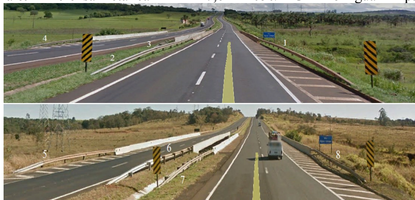
Figura 69 – Defesa metálica – Km 147,6 BR-050/MG – Rio Água Limpa (L2)
