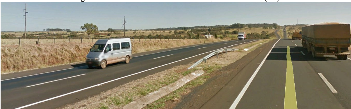
Figura 55 – Defesa metálica – Km 155,7 BR-050/MG (L4)
