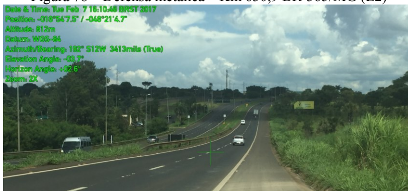
Figura 78 – Defesa metálica – Km 630,9 BR-365/MG (L2)
