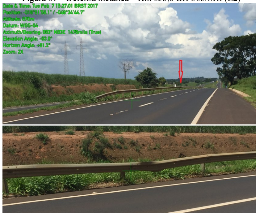
Figura 81 – Defesa metálica – Km 655,3 BR-365/MG (L2)
