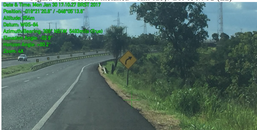
Figura 45 – Defesa metálica – Km 125,7 BR-050/MG (L2)
