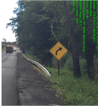
Figura 49 – Defesa metálica – Km 132,2 BR-050/MG (L2)
