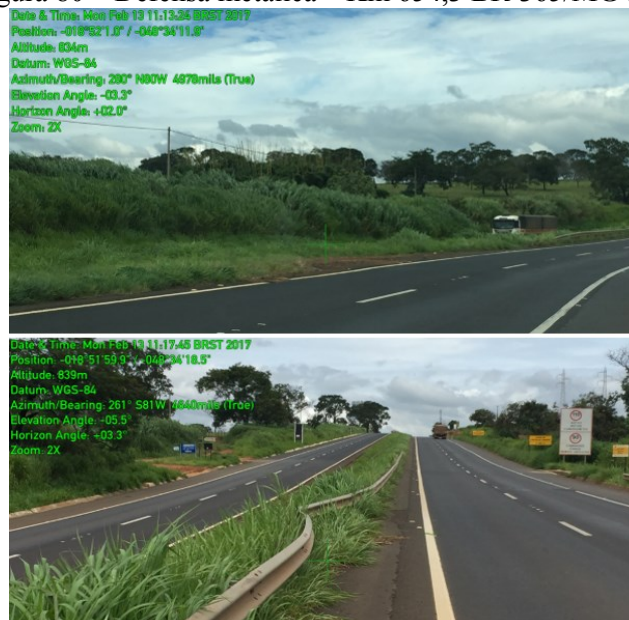
Figura 80 – Defesa metálica – Km 654,3 BR-365/MG (L2)
