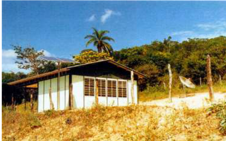
Figura 6. Módulo fotovoltaico em escola pública de Diamantina (MG). Fonte: CEPEL 4 , 1996.
