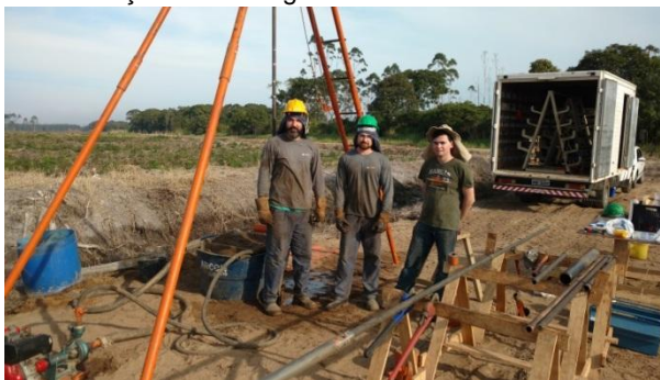
Figura 6.13 - Execução da sondagem SP-01.
