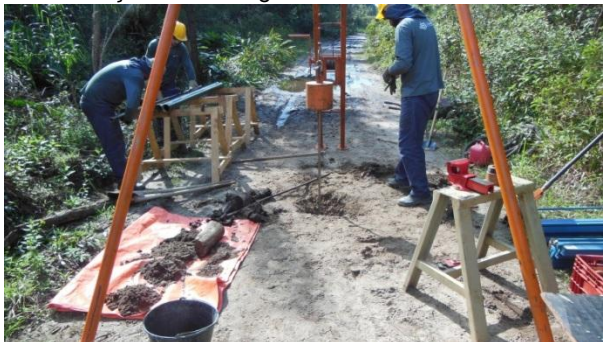
Figura 6.14 - Execução da sondagem SP-02.
