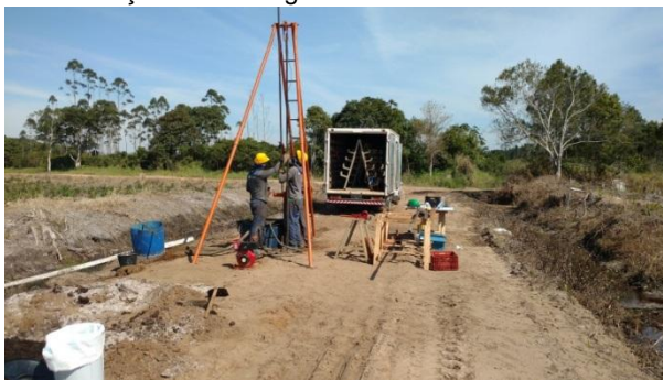
Figura 6.12 - Execução da sondagem SP-01.
