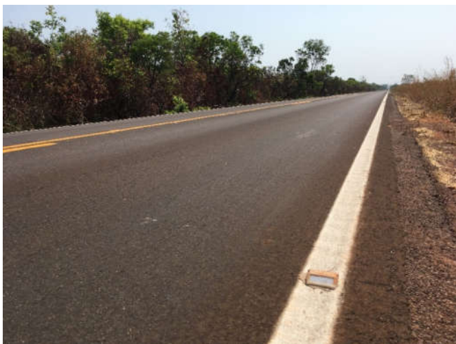
Figura 9 - Tacha tipo 2 instalada na BR-235
