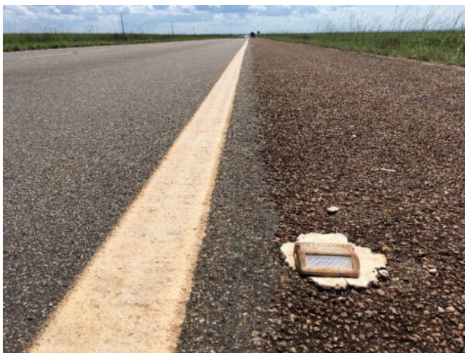
Figura 8 - Tacha tipo 1 instalada na BR-010
