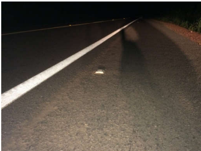
Figura 10 – Tacha tipo 3 instalada na BR- 153
