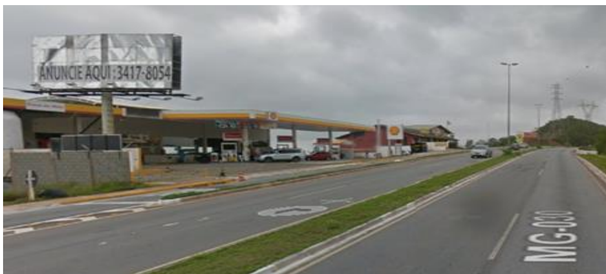
Figura 8 – Painel iluminado na MG-030 em Nova Lima
