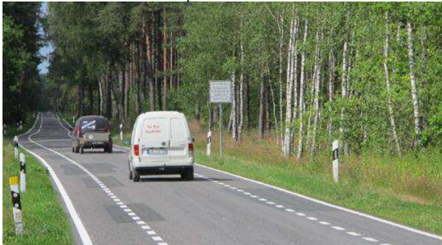
Figura 23 - Projeto-piloto do Estado de Mecklenburg-West Pommerania, Alemanha, onde uma rodovia em meio rural foi adaptada com duas ciclofaixas unidirecionais.
