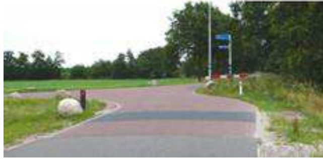
(a) Interseção rural em curva ( Traffic-calming ).
