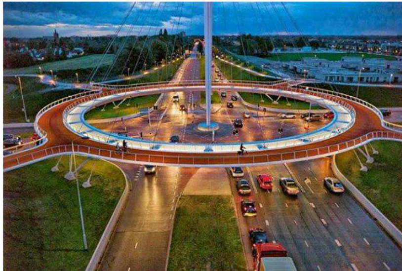
Figura 36 - Rotatória em greides diferentes para pedestres, ciclistas e veículos motorizados – Eindhoven, Holanda.
