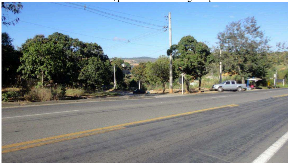
Figura 50 - Acesso precário ao bairro Novo Horizonte no lado esquerdo da via, detalhe para um veículo acessando o bairro, próximo de um abrigo de parada de ônibus.
