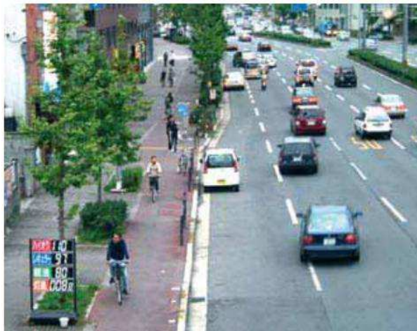
Figura 3 - Ciclovía segregada em calçada, com diferença de tipo e cor do pavimento no Japão.
