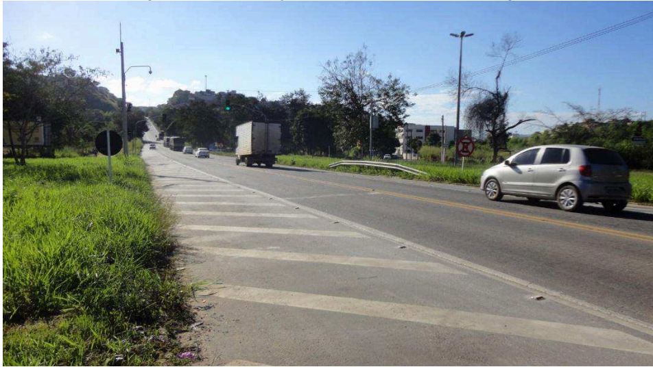
Figura 57 - Interseção de acesso a Honório Fraga
