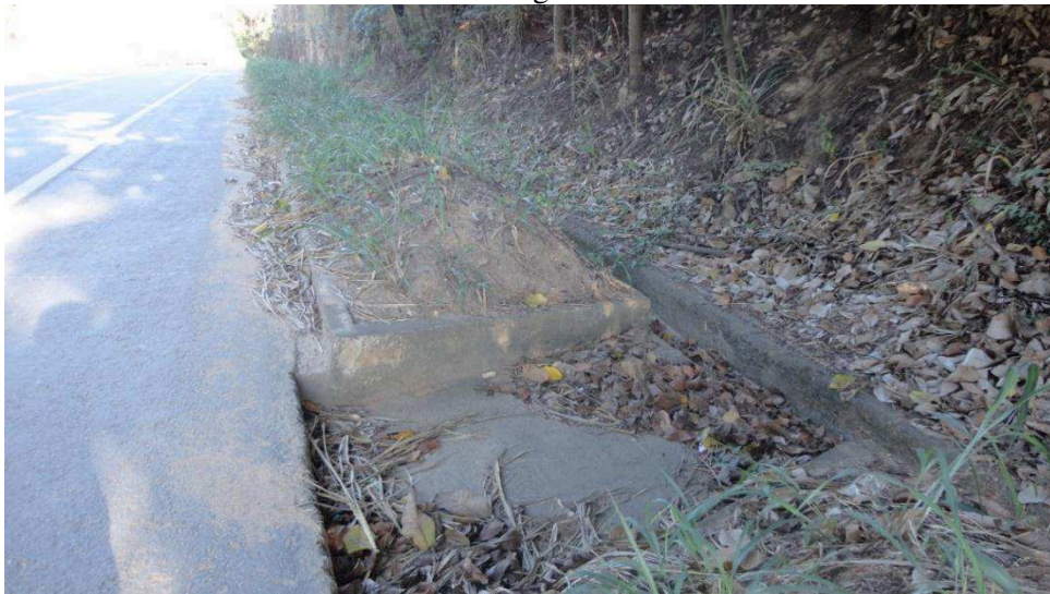
Figura 55 - Faixa do lado direito, vista sentido crescente do acostamento, terrapleno e canaleta de drenagem.
