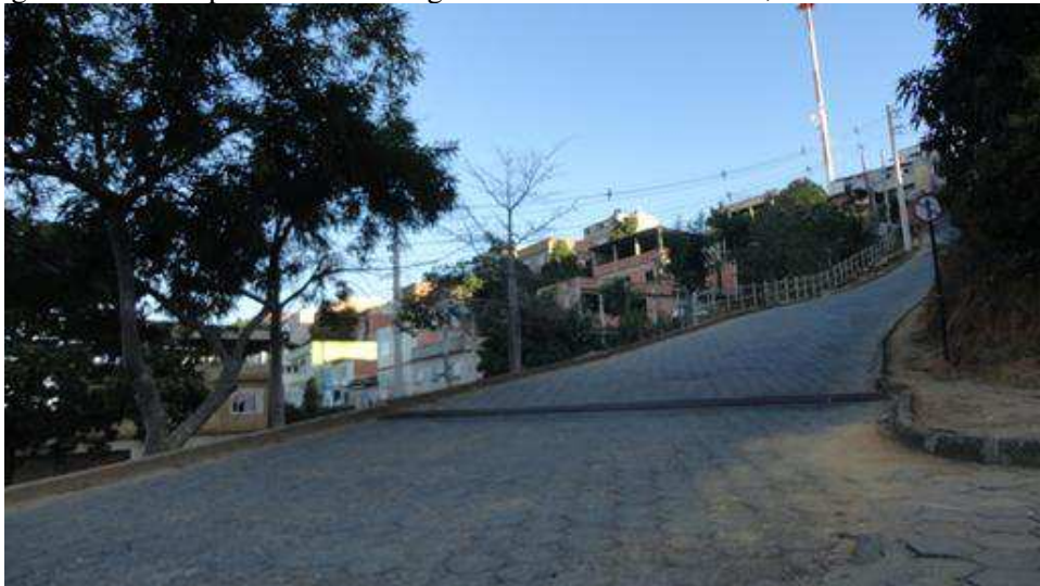
Figura 76 - Exemplo de ladeiras íngremes lindeiras à rodovia, no bairro São Marcos.
