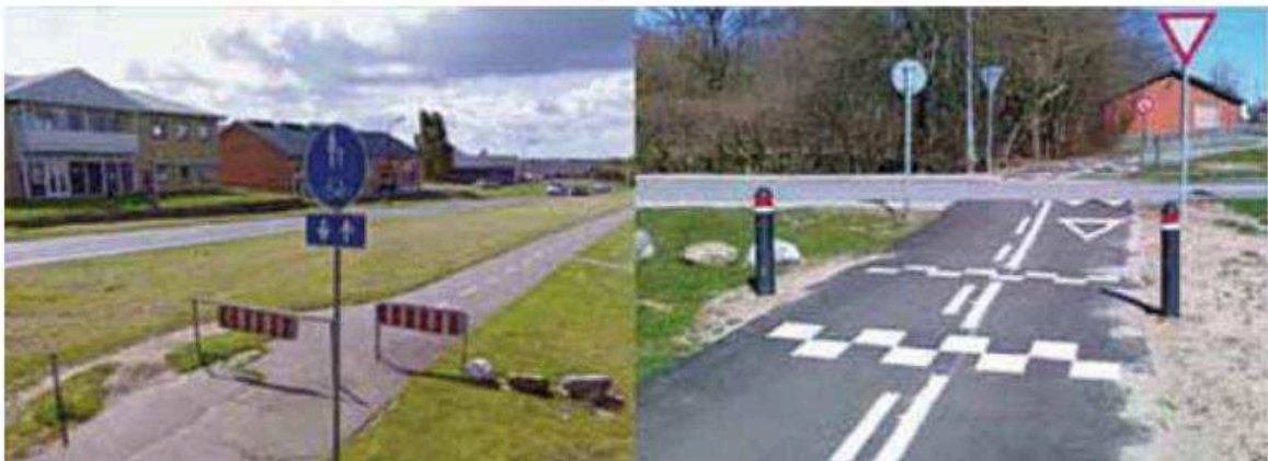
Figura 33 - Medidas para redução da velocidade e aumento da atenção do ciclista antes de cruzamentos rodociclovitários na Dinamarca.
