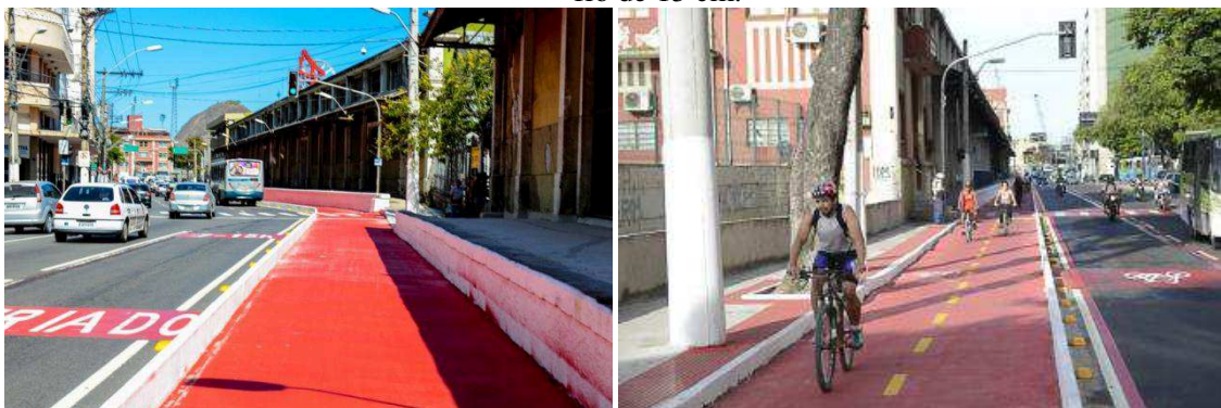
Figura 30 – Ciclovia Segregada junto à Via em Vitória-ES. A separação se dá por meio de um meio-fio de 15 cm.
