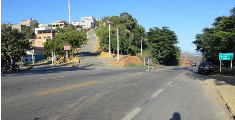
Figura 47 - Trevo informal de acesso a São Marcos. Não há tratamento geométrico. Detalhe para a travessia desprotegida do pedestre.
