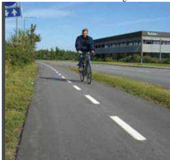
Figura 26 - Ciclovía bidirecional ao longo de rodovia local.
