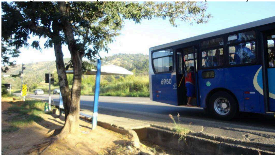
Figura 54 – O embarque é feito sobre a canaleta, tampada com laje.
