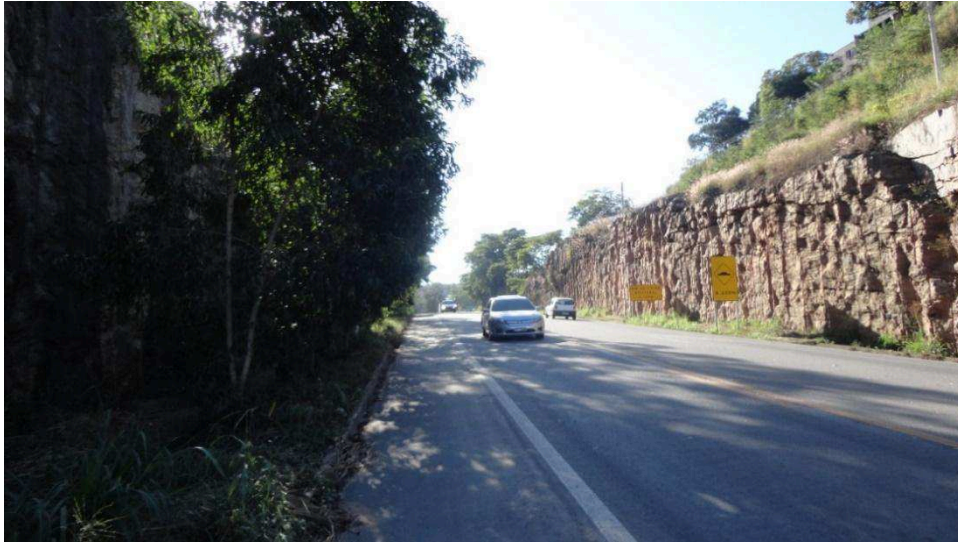
Figura 49 – Cortes em rocha em ambos os lados delimitam os primeiros metros do segmento em estudo.
