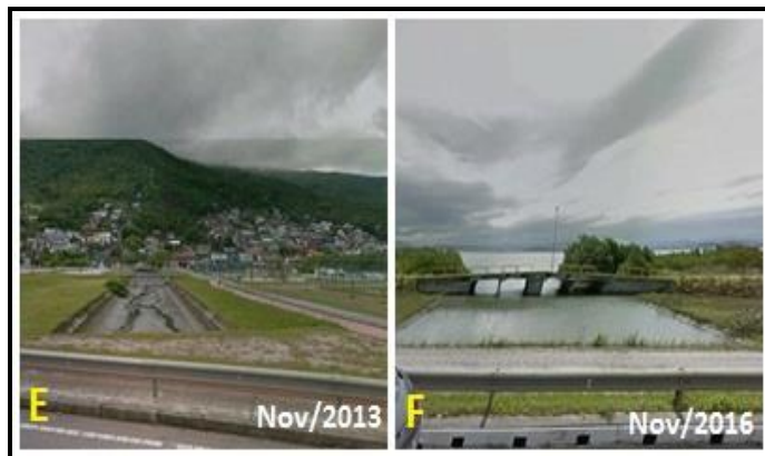
Figura 12 – Canais de drenagem para escoamento das águas pluviais. Fonte: Imagens Software Google Earth Pro.
