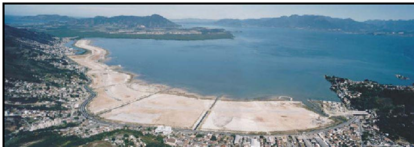
Figura 5 – Construção do aterro da Baía Sul e ocupações adjacentes. Fonte: PROCHNOW; DAL SANTO (2009).
