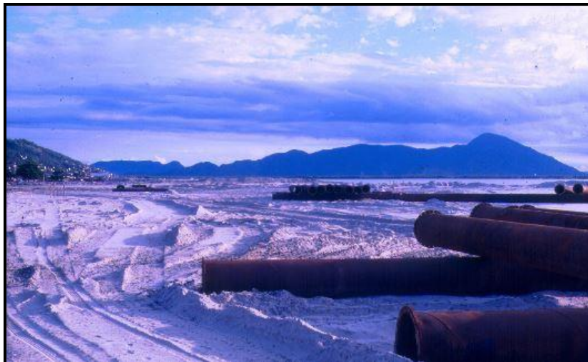
Figura 3 – Construção do aterro da Baía Sul em 1998. Fonte: RIBAS (2012).
