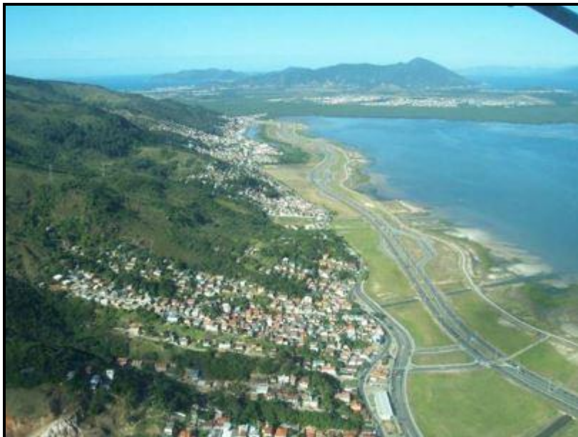
Figura 4 – Vista aérea da Via Expressa Sul, Florianópolis/SC. Fonte: UNIVALI/CTTMar (2012).
