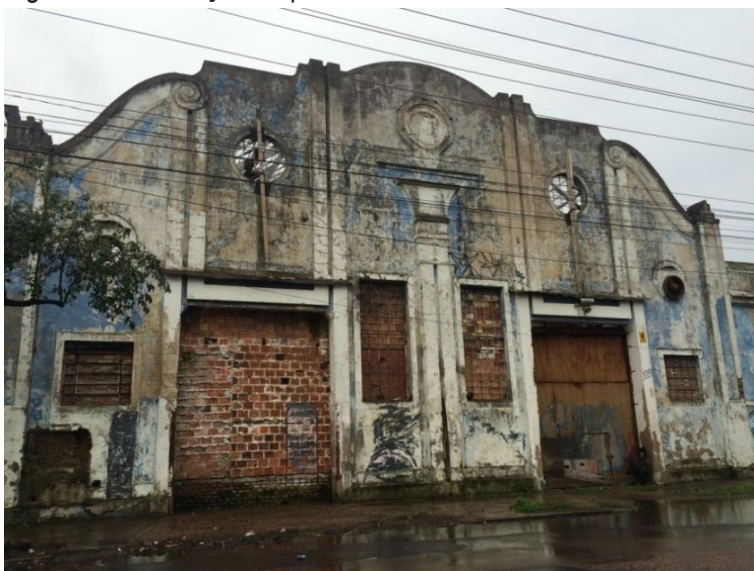
Figura 15: edificações e pessoas abandonadas no IV distritos.
