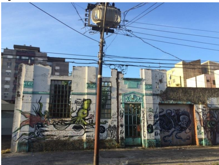
Figura 13: Casa demolida no IV distrito.
