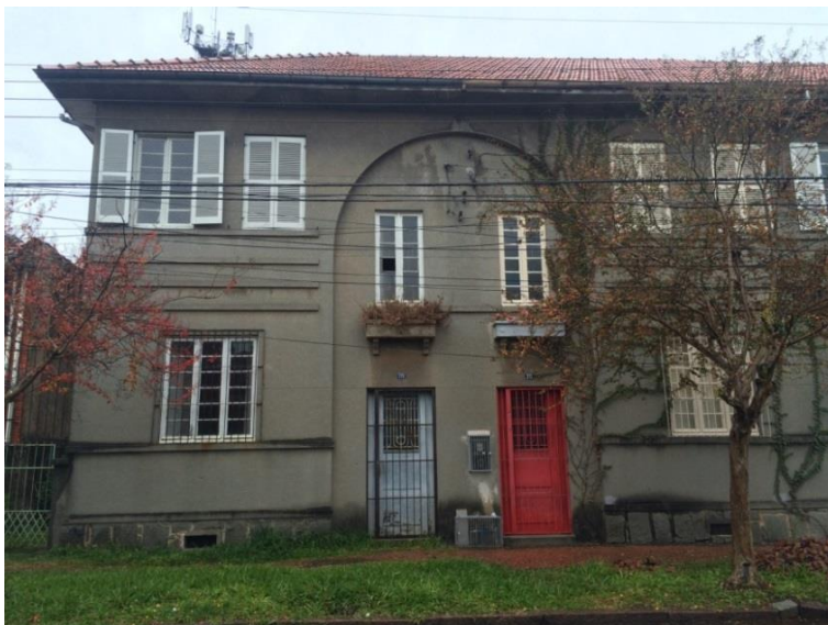
Figura 14: edifício com revestimento Cirex na fachada.
