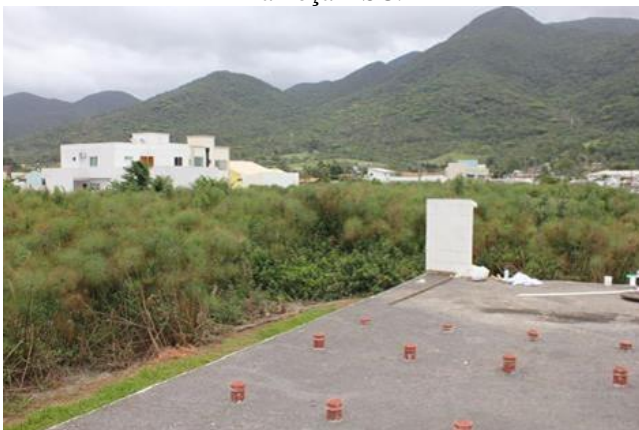
Figura 14. ETE composta por RAC seguido de WCV e tanque de desinfecção implantada em condomínio residencial no município de Palhoça – SC.
