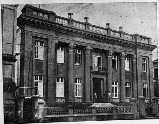
FACHADA DO CONSERVATORIO MINEIRO DE MUSICA (CAPITAL)
