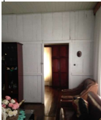
Figura 87 - Interior da sala e porta do quarto do casal, no pavimento térreo
