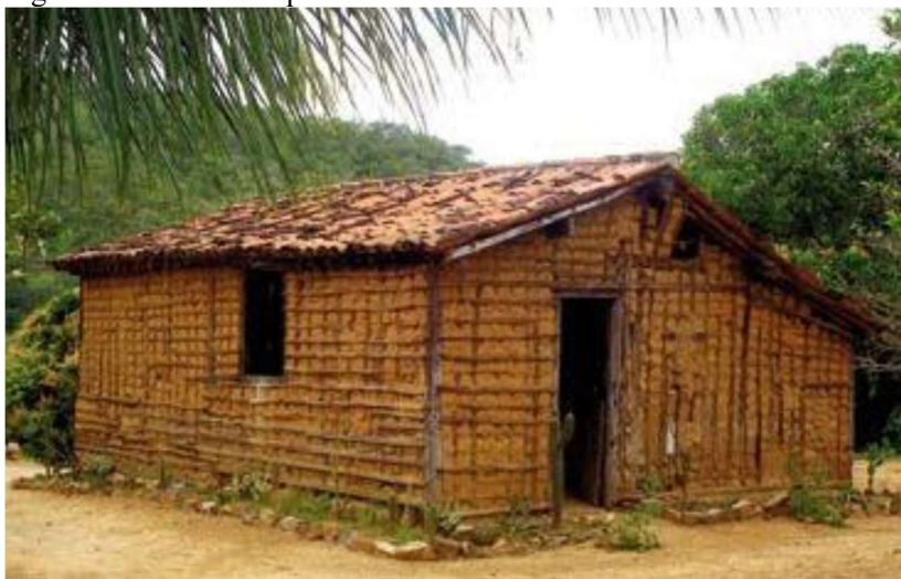
Figura 12 - Casa de taipa
