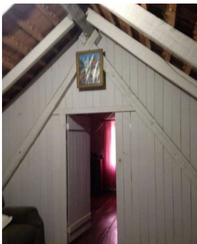
Figura 88 - Interior da sala no pavimento superior
