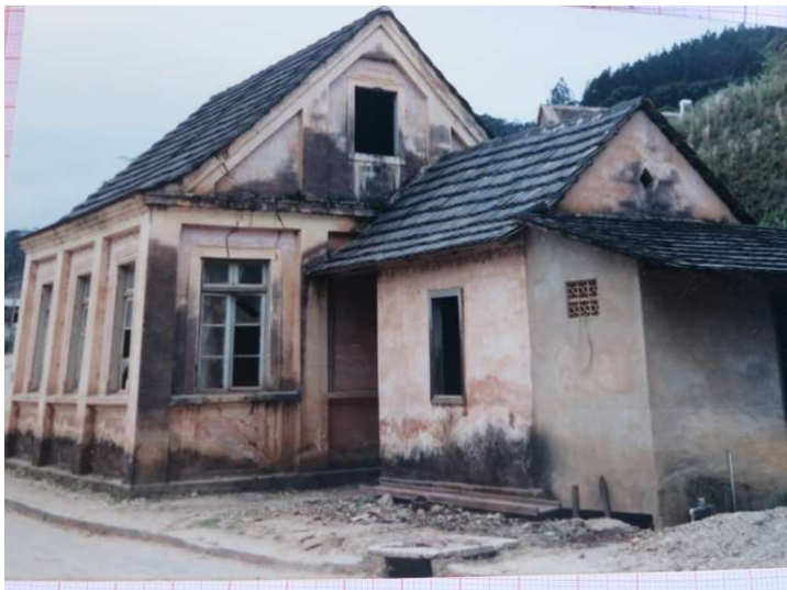
Figura 101 - Antes da reforma e ampliação
