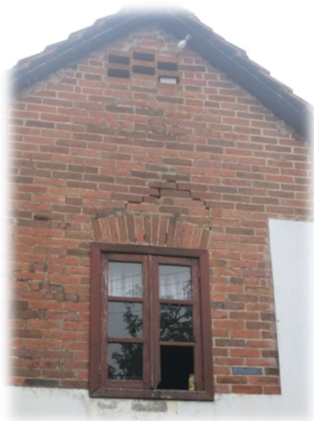
Figura 51 - Oitão da cozinha da casa de Pasquale Fiamoncini
