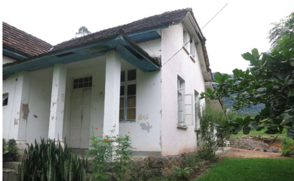
Figura 79 - Residência de Arcênio Macopi (Rodeio). Detalhe da fundação da edificação e muro aos fundos
