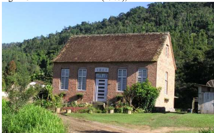
Figura 31 - Casa em Rodeio (1903), situada no Bairro Gávea
