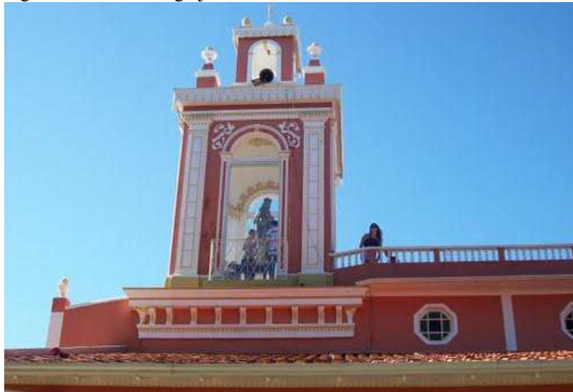
Figura 39 - Torre da Igreja Nossa Senhora do Bom Socorro – Nova Trento
