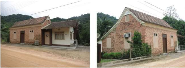
Figura 32 - Dois ângulos de casa em Rodeio, SC, construída em 1909
