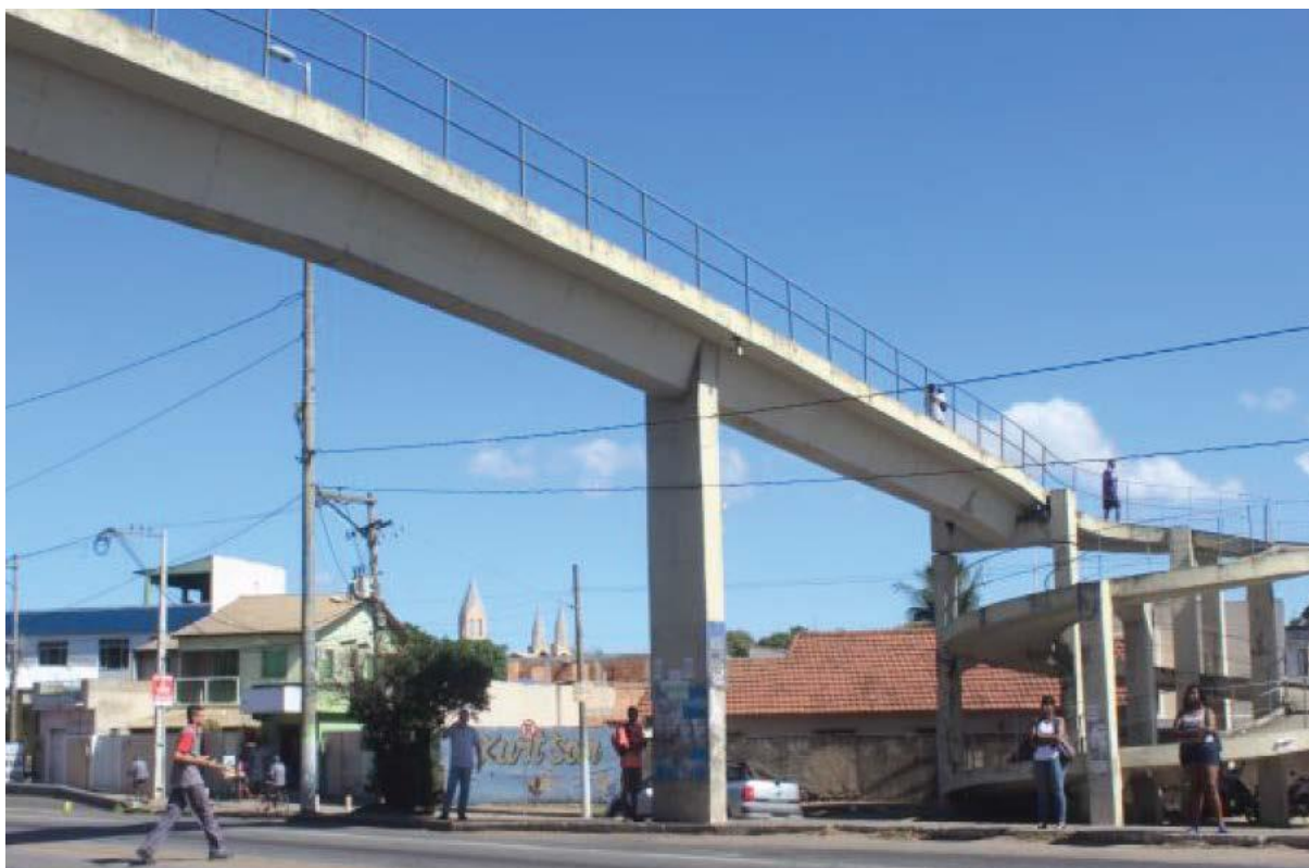
Figura 27 – Travessia irregular de pedestres – Rodovia BR-101 (Campos dos Goytacazes - RJ)
