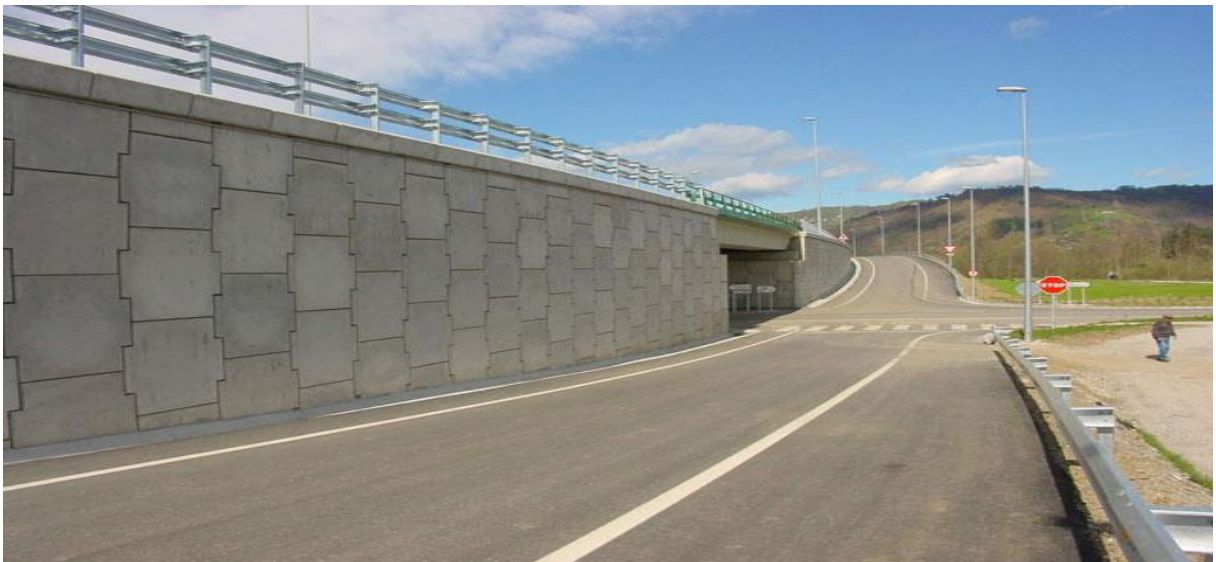
Figura 18 – Exemplo de pista elevada contida por Terra Armada
