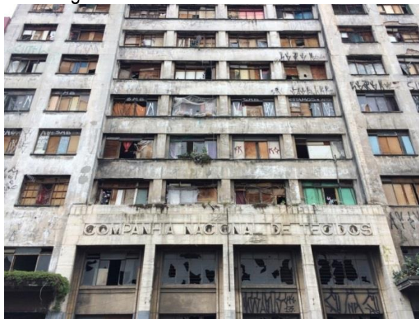
Imagem 8: Fachada dos fundos do edifício.
