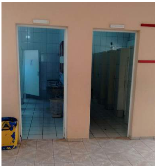
Figura 1.1 – Entrada dos sanitários
