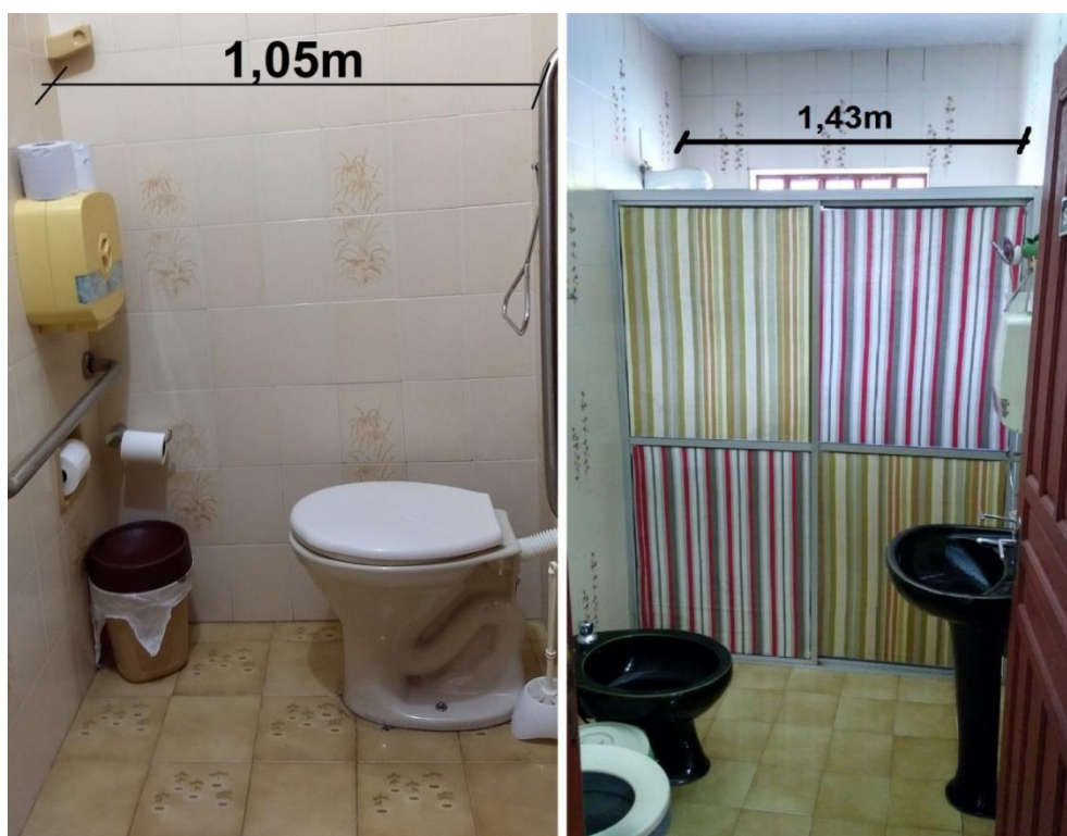
Figura 10 - Sanitário com Acesso a Cadeirante e Banheiro sem Acesso a Cadeirante
