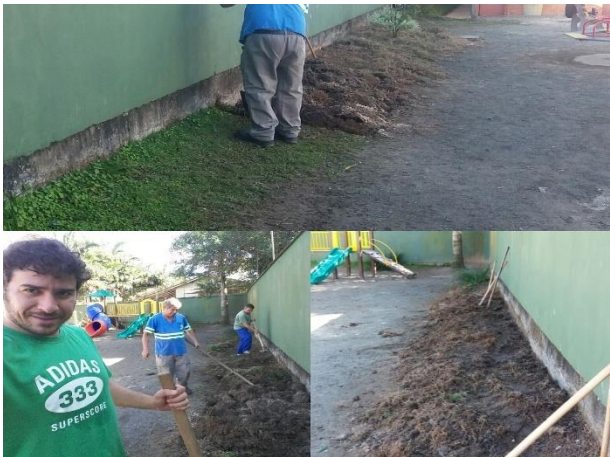
Figura 4 – Construção de canteiros
