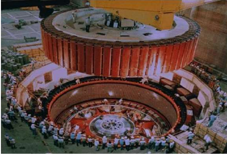
Figura 11. Rotor de polos salientes.
