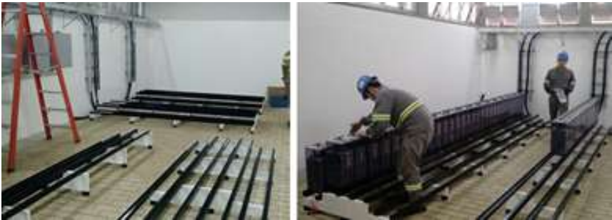
Figura 38. Posicionamento dos racks e instalação das células acumuladoras.
