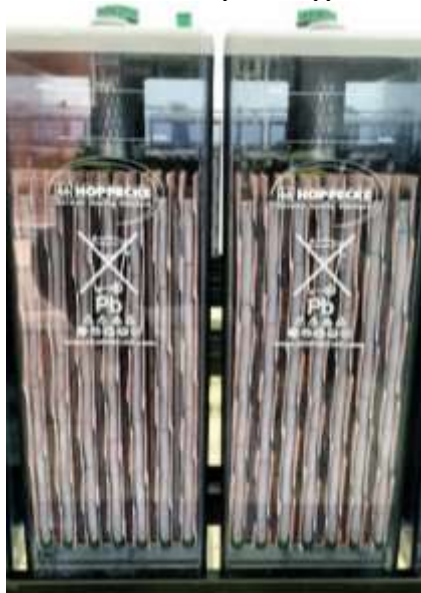
Figura 27. Detalhe nas placas positivas, negativas e dos separadores de uma célula chumbo-ácida da empresa Hoppecke Batterien.
