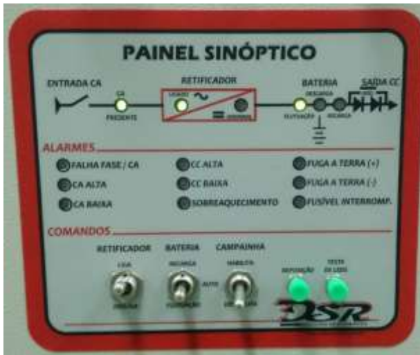
Figura 19. Painel sinóptico do retificador industrial DSR.
