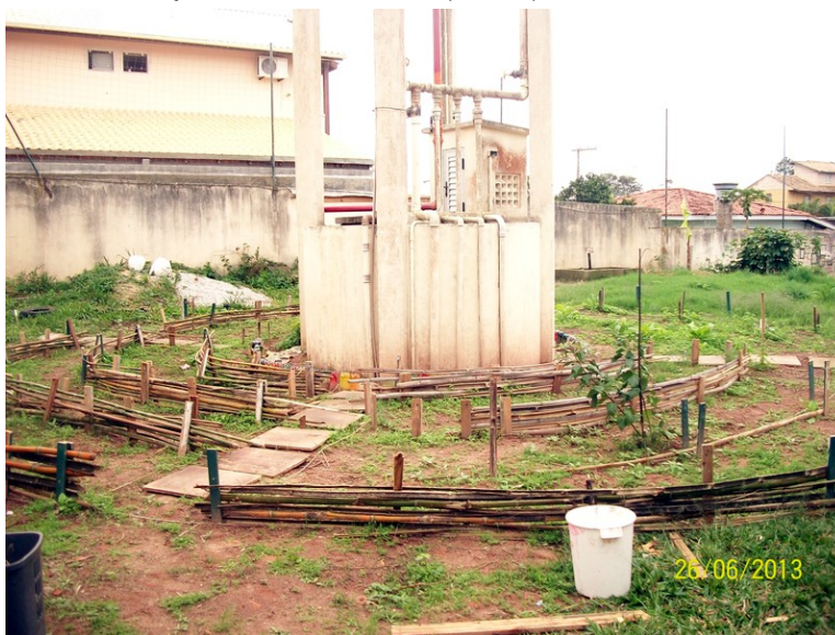
Figura 9: Construção da horta-mandala (zona 1).
