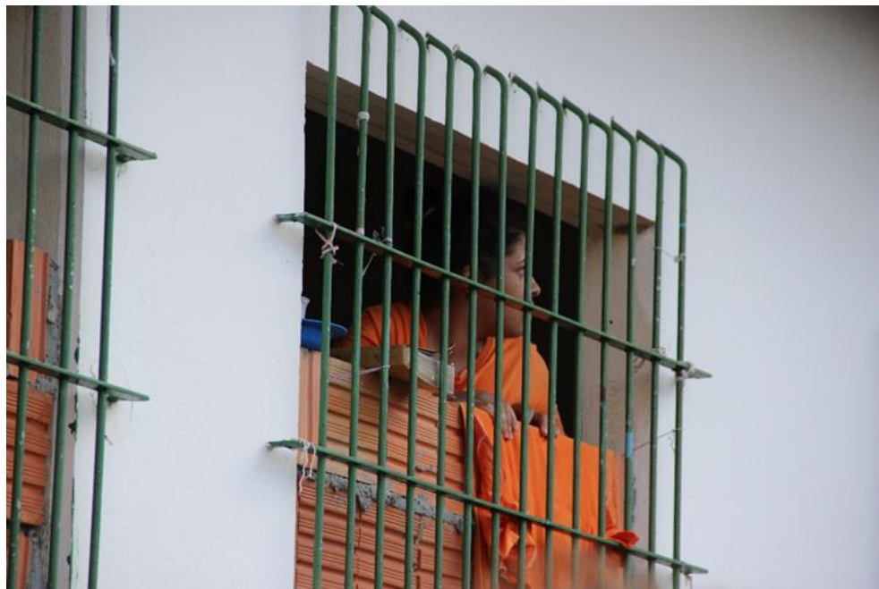
Figura 03: Janelas cobertas por tijolos
