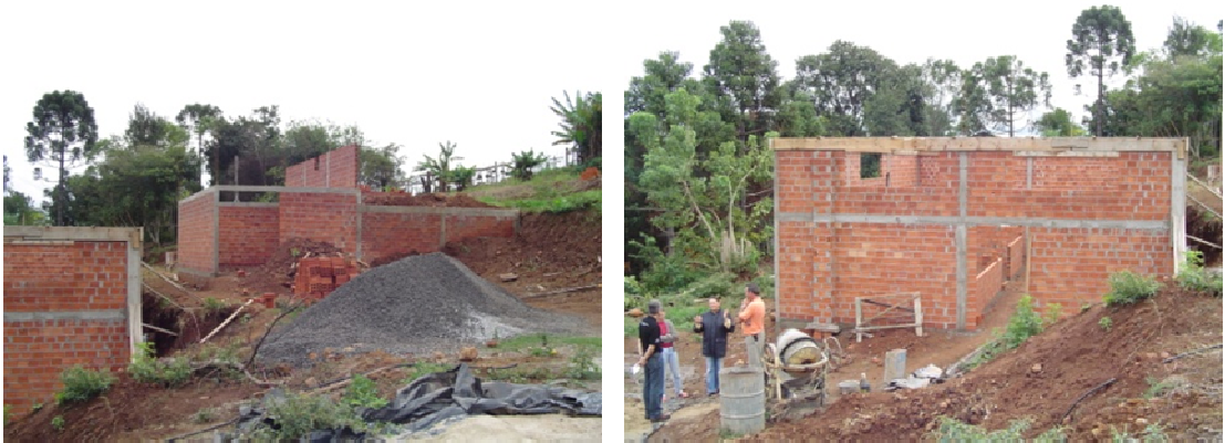
Vista geral do alambique em construção.
