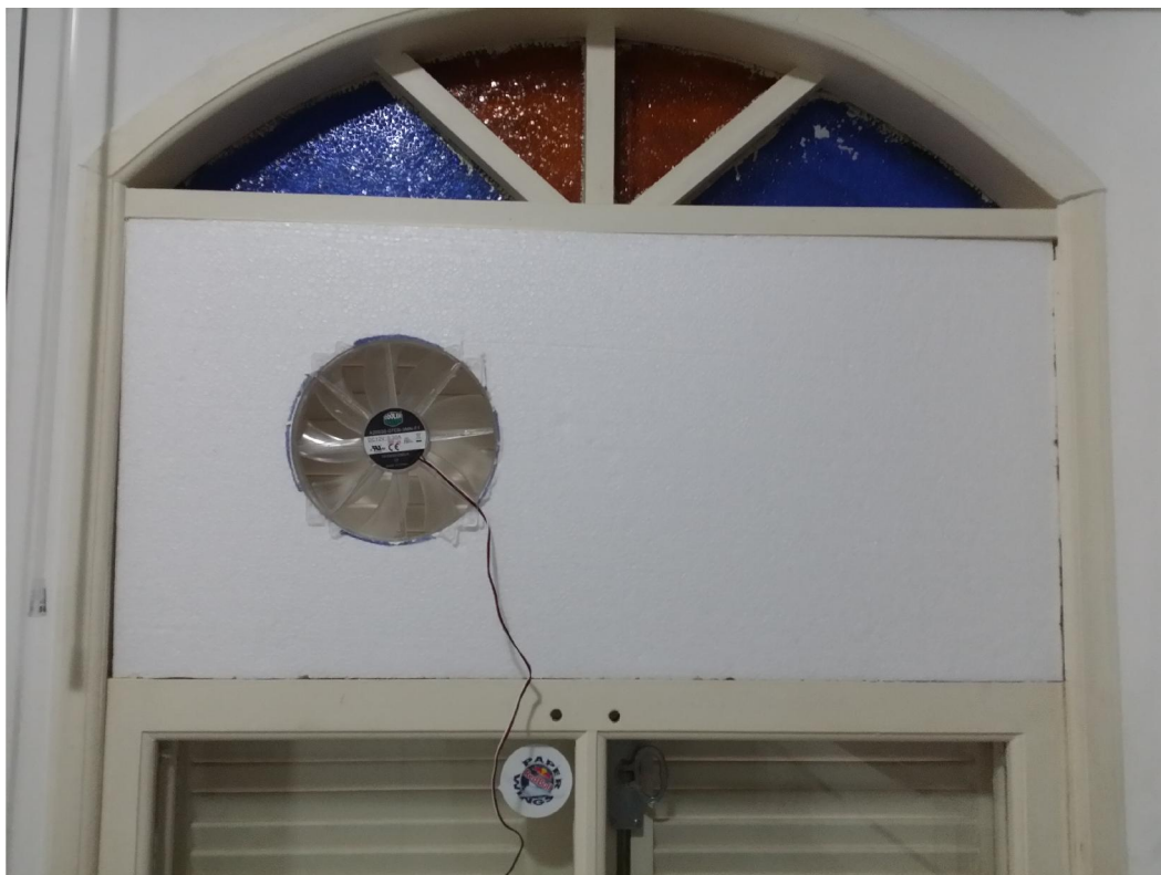
Figura 10 - Janela com ventoinha anexada
