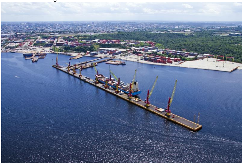
Figura 6 - Terminal de Uso Privado de Chibatão
