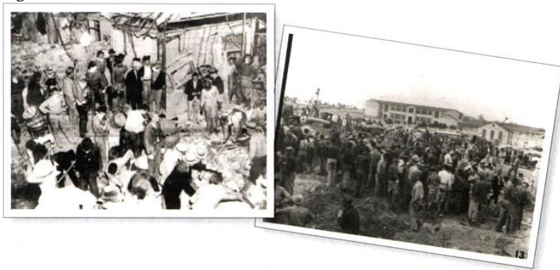
Figura 2.1 - Fotos do acidente ocorrido na escola de New London.
