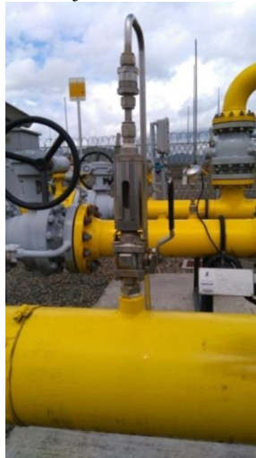
Figura 2.8 - Ilustração de um injetor de odorante.
