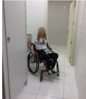
Figura 71 - sanitário feminino – bancada lavatório
