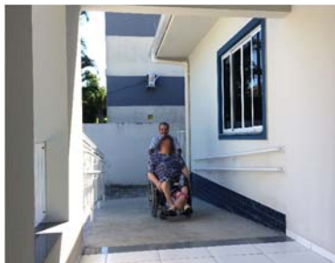
Figura 76 - Rampa de acesso
