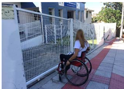
Figura 64 - Portão da rampa fechado
