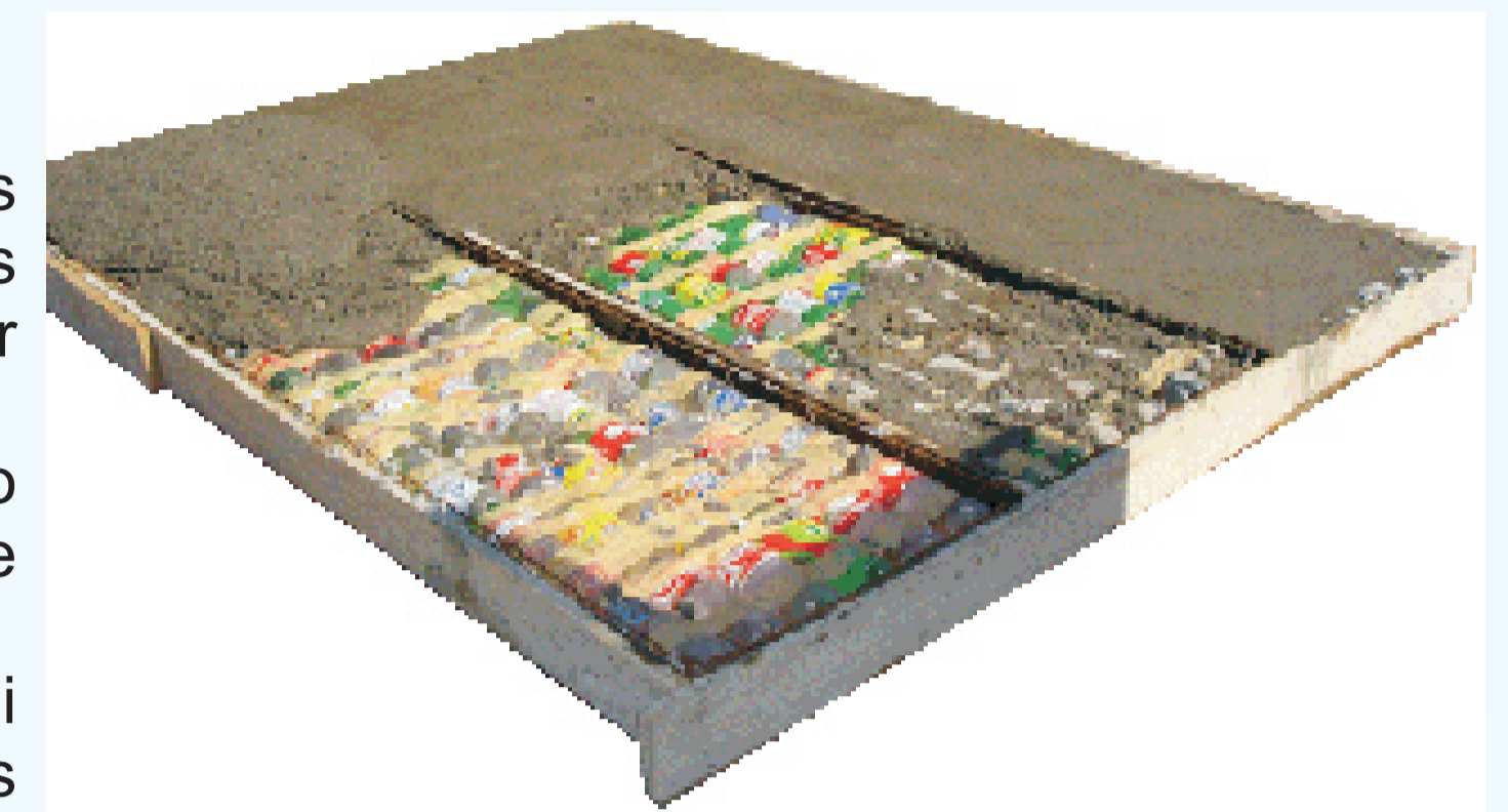
Imagem 3: Processo de concretagem dos painéis. (Fonte: http://www.labsico.ufsc.br/casa_pet.html - Acesso em 14/10/2011)
