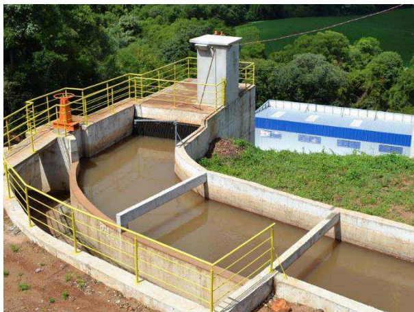
Figura 14 – Câmara de Carga da CGH Mambuca
