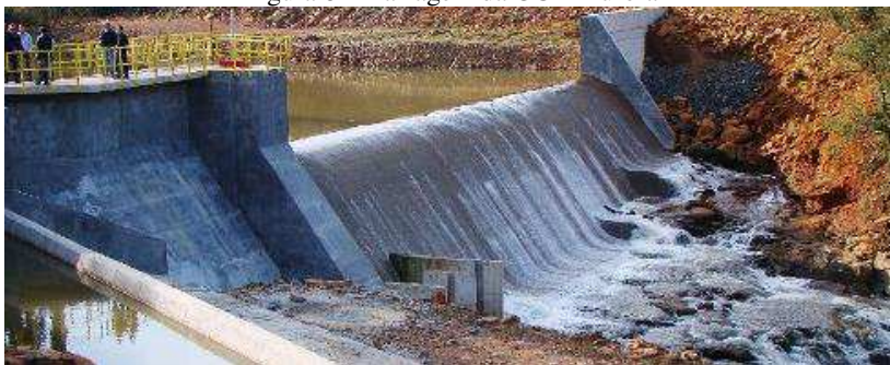
Figura 8 – Barragem da CGH Aurora
