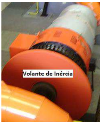
Figura 31 – Volante de Inércia da CGH Pacheco
