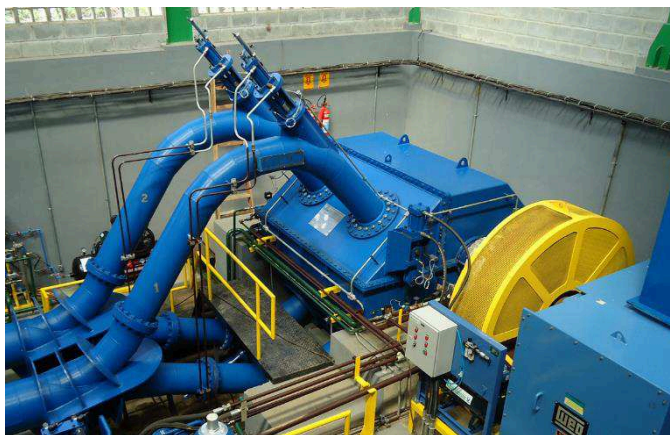
Figura 24 – Turbina Pelton Comercializada pela WEG
