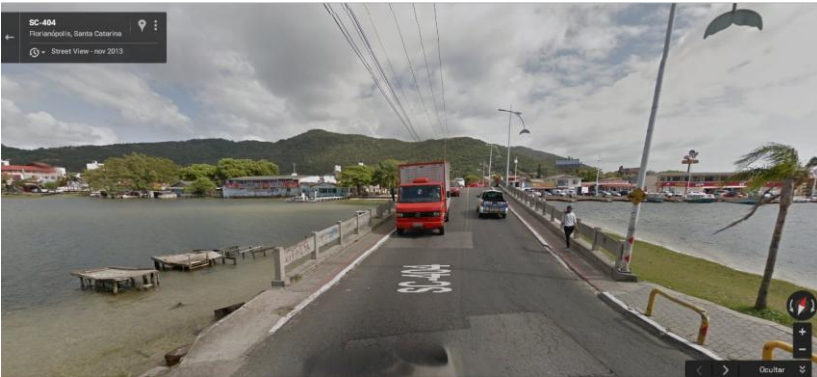
Figura 69 – Imagem com situação do tipo 1 – ponte sobre a Lagoa da Conceição.
