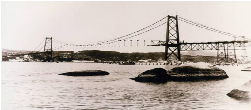
Figura 16 – Construção da ponte Hercílio Luz, 1926.
