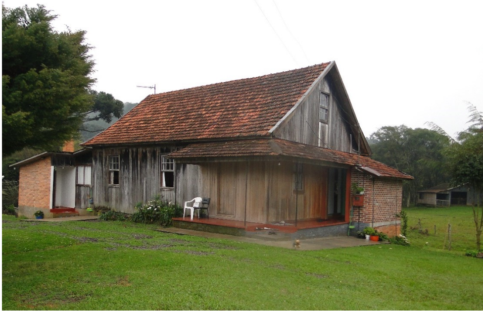
Figura 5: Casa nos moldes italianos de 1940 (sótão).
